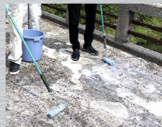
② 高浸透型床版防水工
