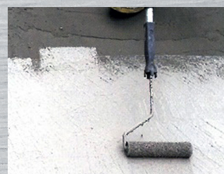
④ 表面保護工
