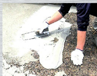
③ 表面補修・不陸修正工※
