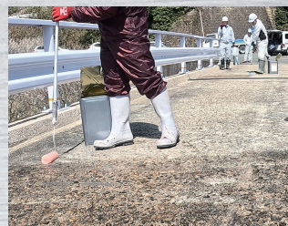
① 亜硝酸リチウム塗布工
