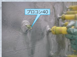
プロコン40先行注入の状況
