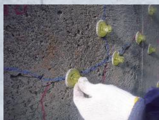
座金設置状況
