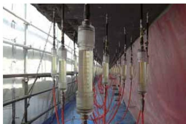
図 3-21 内部圧入工法の施工状況
