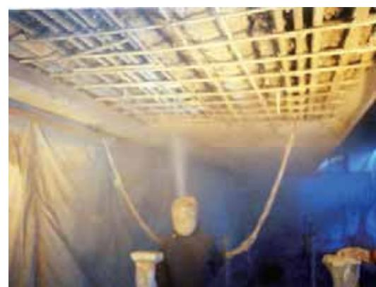
図2-26 断面修復工法(吹付け工法)
