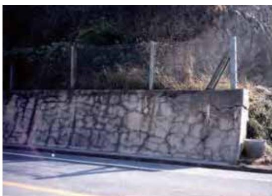
図2-30 擁壁のひび割れ
