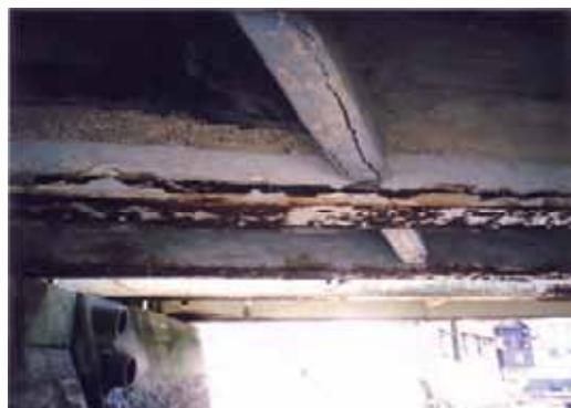
図2-6 補修箇所の再劣化
