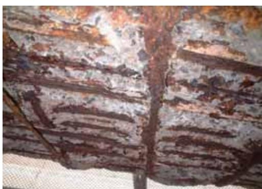
図2-5 主桁下面の鉄筋腐食
