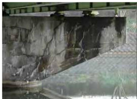
図2-31 橋脚はり部のひび割れ
