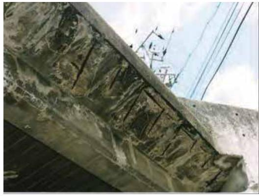
図 2-18 張出し床版下面の鉄筋露出
