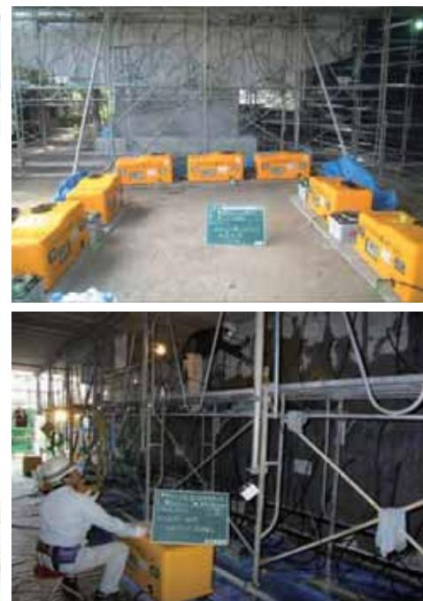
図2-42 内部圧入工法の施工状況
