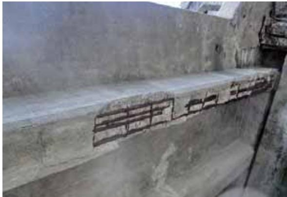
図 2-1 塩害による劣化の例
