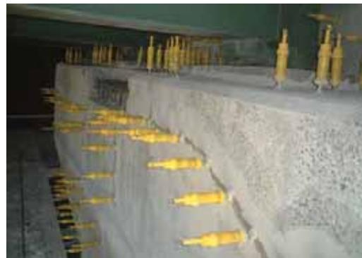
図2-9 ひび割れ注入工法
