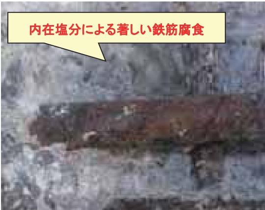
内在塩分による著しい鉄筋腐食
