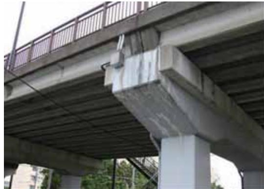
図 2-35 橋脚はり部の再劣化
