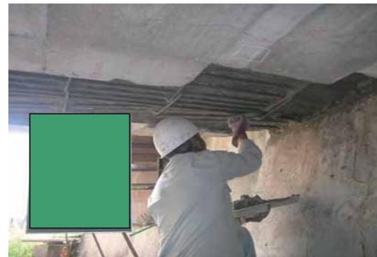
図 3-24 断面修復工法の施工状況
