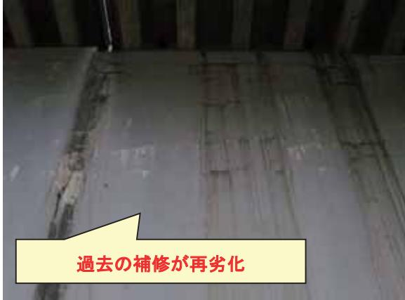
【施工前の橋台たて壁再劣化状況】
