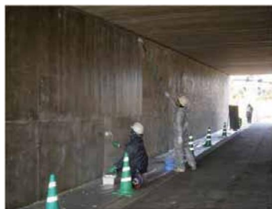
図 3-28 表面含浸工法の施工状況
