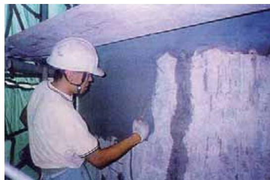
図3-17 表面被覆工法の施工状況
