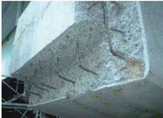
図 2-34 ASR による鉄筋破断
