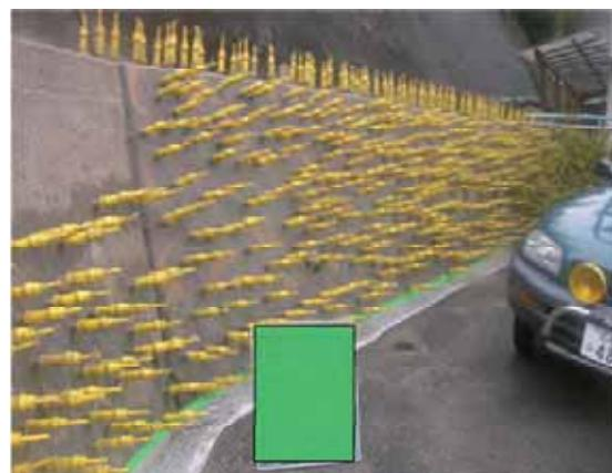
図 3-33 ひび割れ注入工法の施工状況
