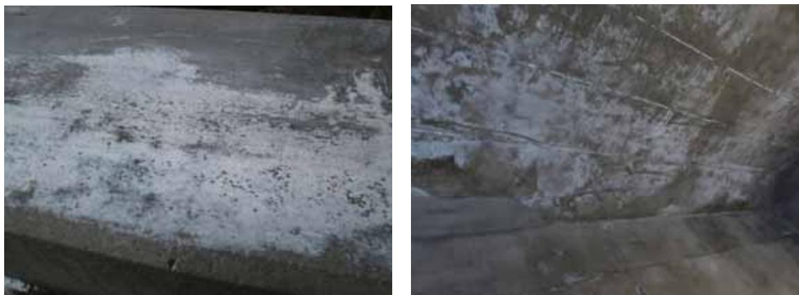
図3-14 プロコンガードシステム施工後の白化現象の例
