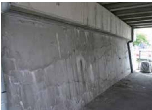
図 2-36 橋台の再劣化
