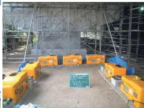
図 3-35 内部圧入工法の施工状況
