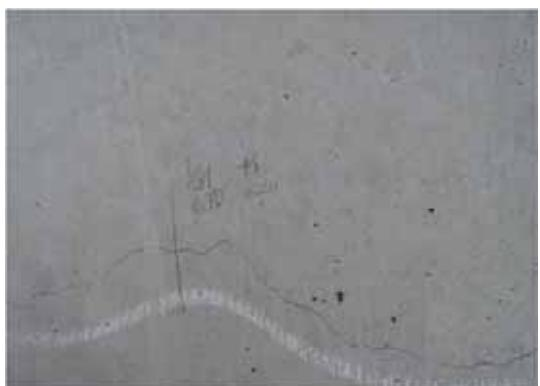
図 2-37 RC 卷立て後の再劣化
