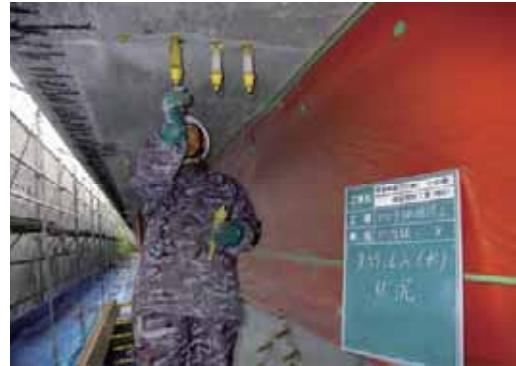
図 2-21 ひび割れ注入工法
