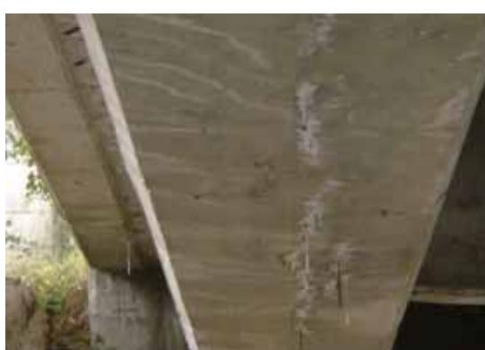
図2-32 PC桁下面のひび割れ
