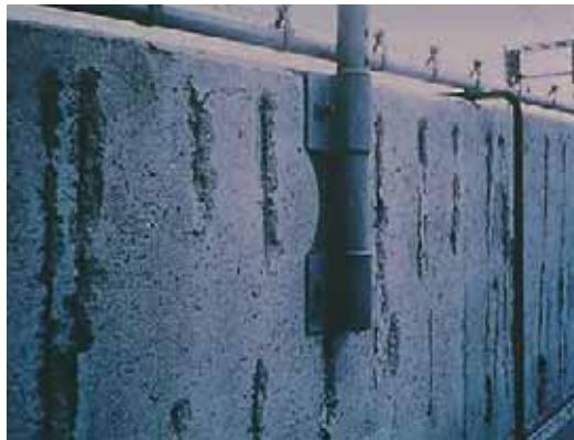
図 2-17 壁高欄のコンクリートはく落
