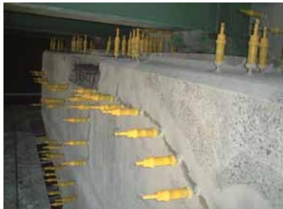
図3-19 ひび割れ注入工法の施工状況
