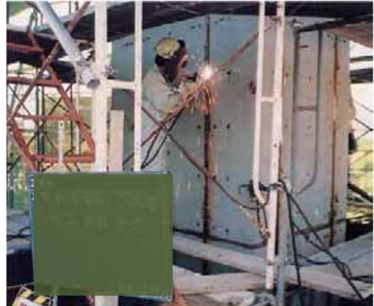
図 2-43 鋼板巻き立てによる膨張拘束
