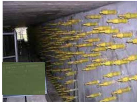
図2-40 ひび割れ注入工
