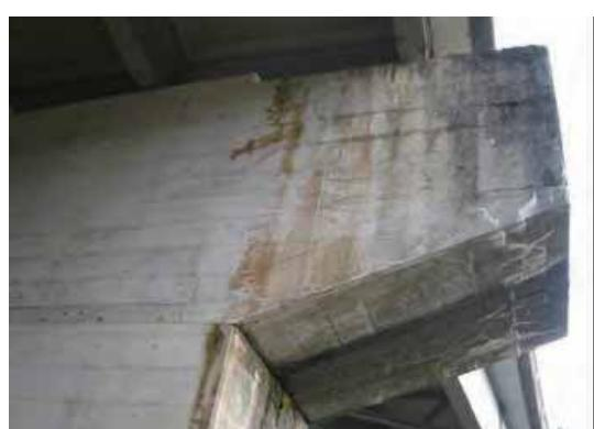
図2-33 部位によるひび割れの状況
