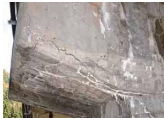
図 2-28 ASR による劣化
