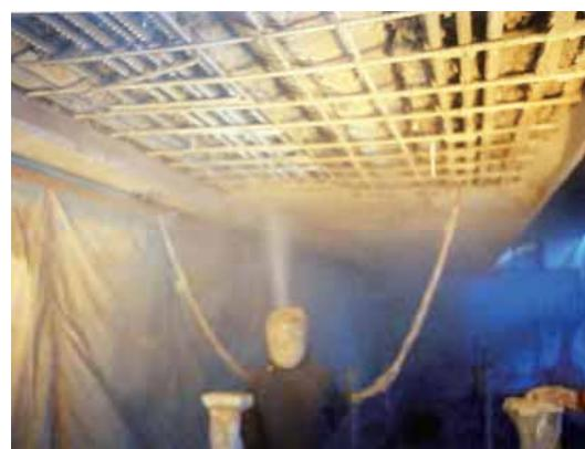
図2-14 断面修復工法(吹付け工法)
