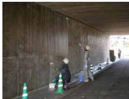
図3-13 表面含浸工法の施工状況
