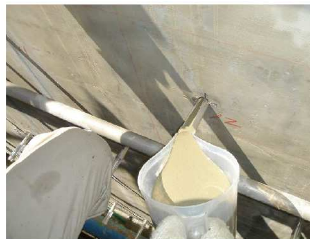
写真 4-7 圧入孔充填状況
