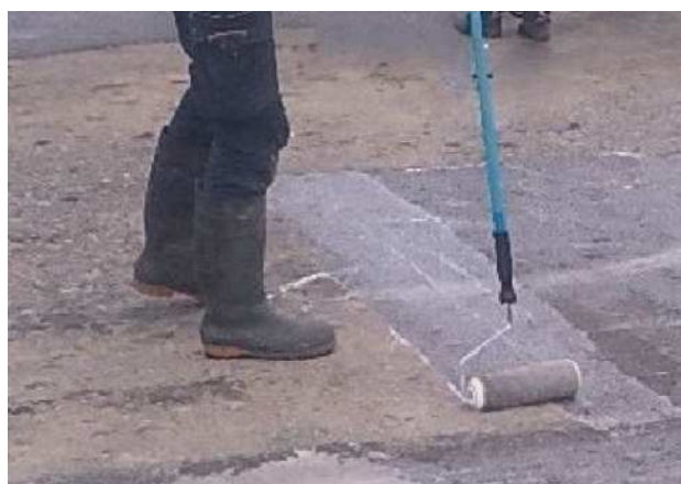
③プライマー塗布工
