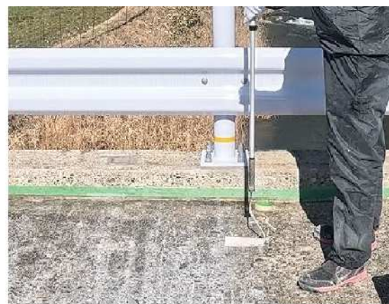
写真 4-3 高浸透型床版防水材(1層目)塗布工の施工状況
