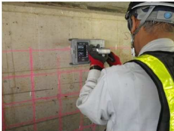
写真 4-4 鉄筋探査状況
