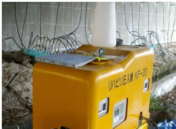
写真 4-6 加圧パッカー装着及び配管状況
