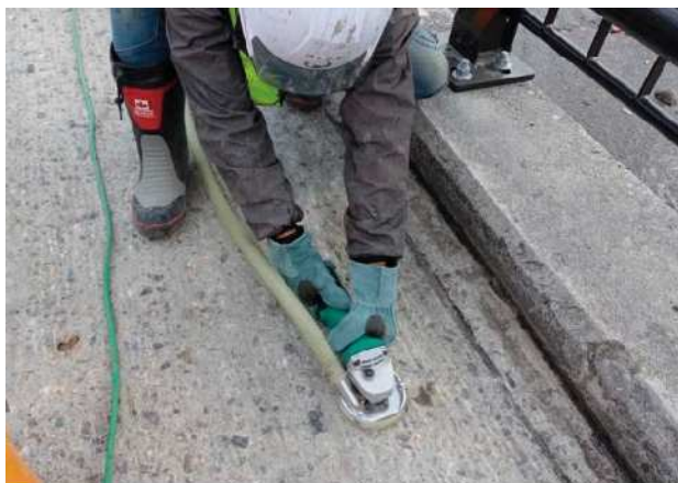
①下地処理工
