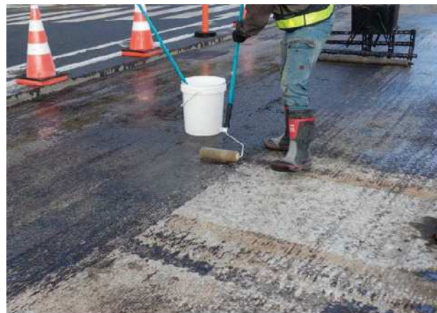
②亜硝酸リチウム塗布工
