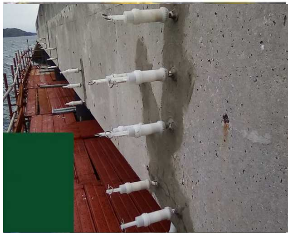
写真 4-1 表面漏出防止工(ひび割れ注入工)
