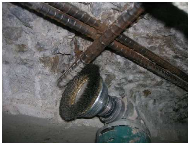
写真 4-3 鉄筋ケレン状況
