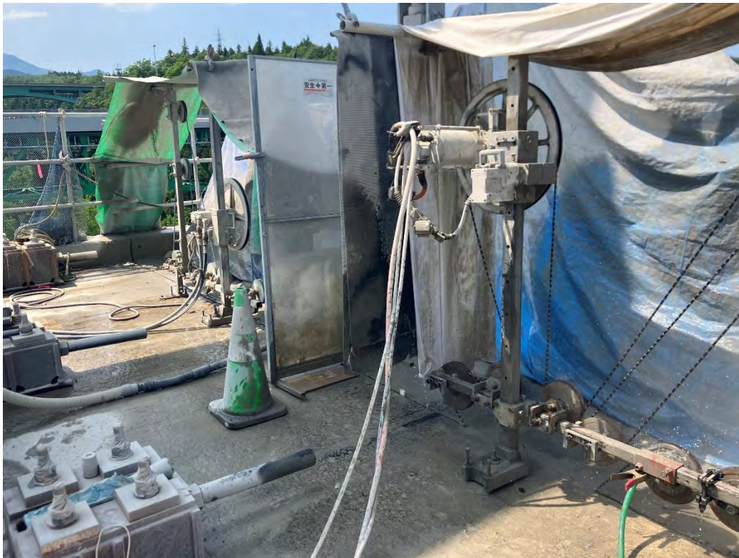
橋面上に設置したワイヤーソー
