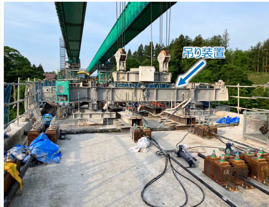
橋形クレーンで撤去するセグメントを 仮吊りした状態
