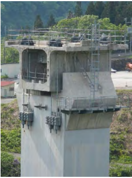
仮固定PC補強の写真
