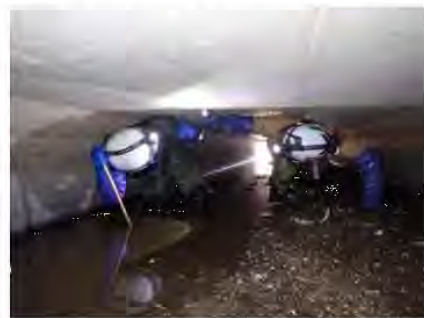
進入困難箇所の近接目視
