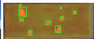
赤外線画像の解析結果 (緑枠内が検出した損傷)
