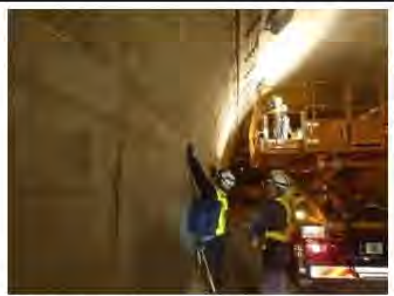
近接目視により、覆工のひび割れ等の有無を確認
