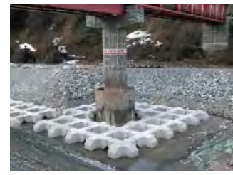
＜ 根固めブロック設置＞
