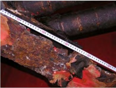
鋼桁の腐食
