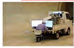
レーザにより覆工内部のうきを計測
