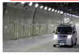
全方位画像を取得可能なカメラ及びレーザ等により覆工表面を計測
