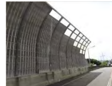
大型遮音壁を要する橋梁
