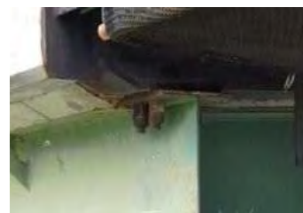
ボルト腐食（左：近接目視、右：ドローン）
