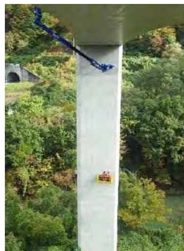
ゴンドラ車による高橋脚の点検
