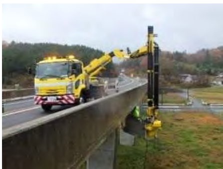
橋梁点検車を活用した点検の実施状況
