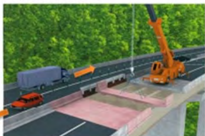
床版取替え工事のイメージ
