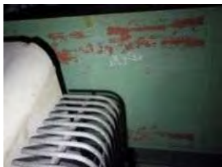
塗膜劣化（左：近接目視、右：ドローン）
