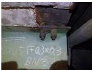
ボルト腐食（左：近接目視、右：ドローン）
