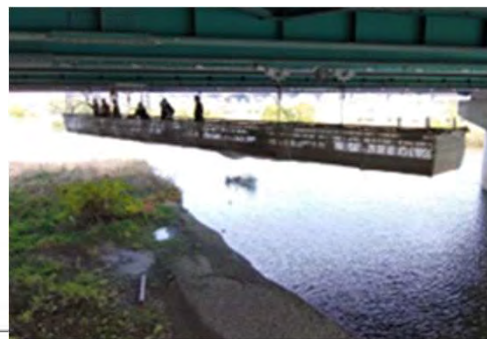
移動式足場を活用した点検の実施状況
