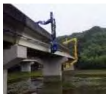
橋梁点検車の活用
