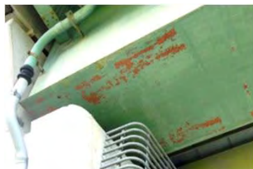
塗膜劣化（左：近接目視、右：ドローン）
