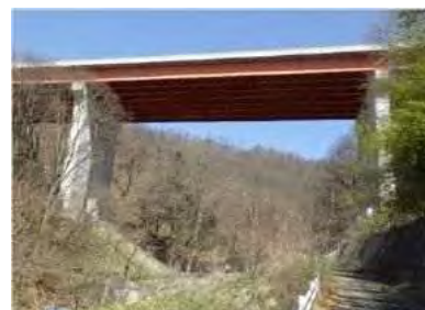
桁下が谷地形の橋梁
