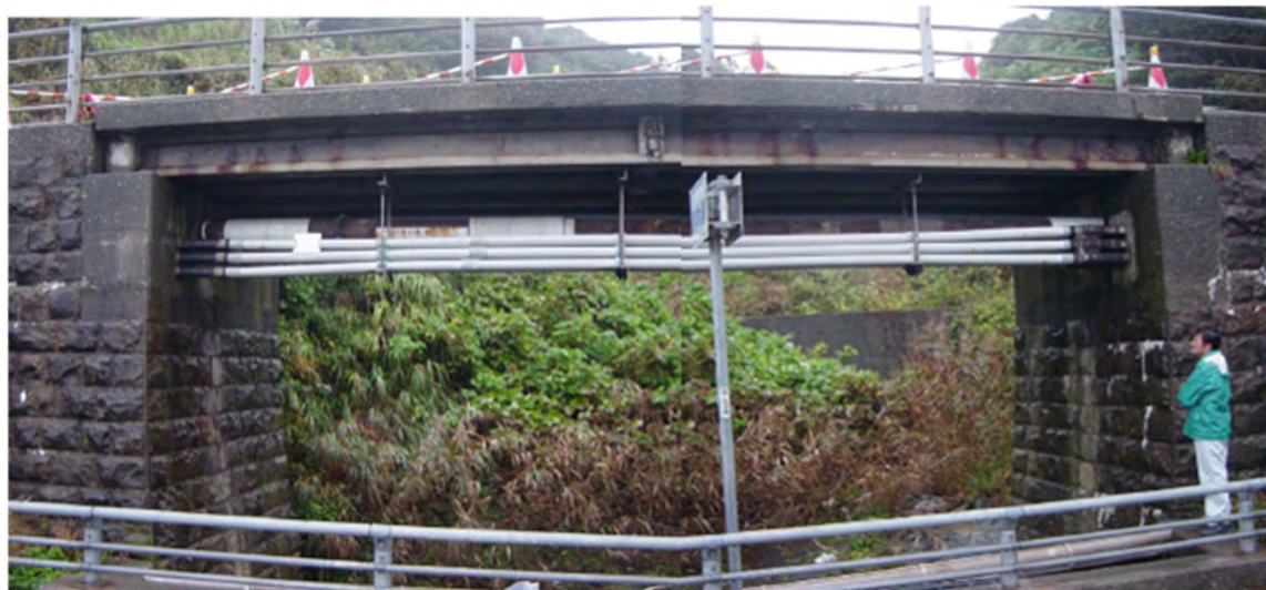
PC桁(歩道橋)
