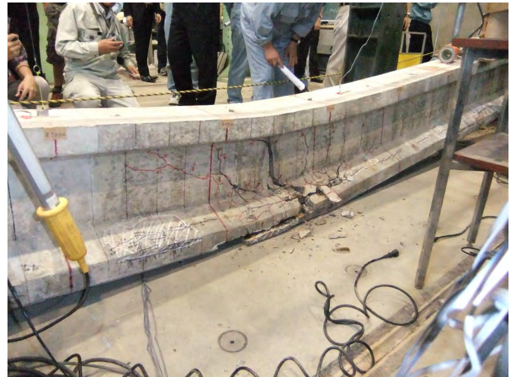
B 桁 (曲げ破壊)
