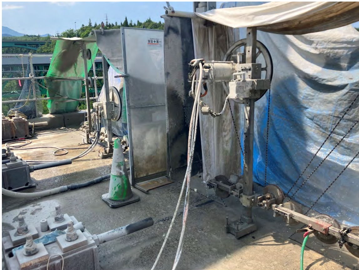
橋面上に設置したワイヤーソー
