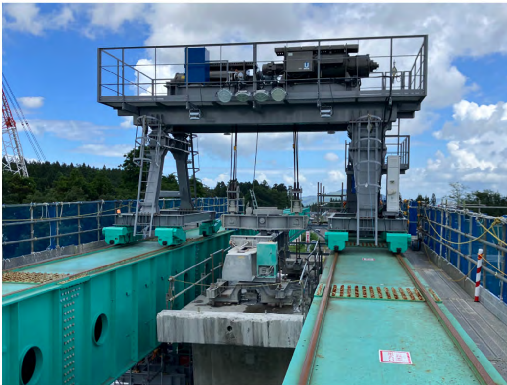
架設桁上に設置した70t級の橋形クレーン (セグメント最大重量60t/体)
