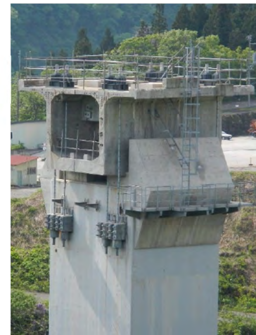
仮固定PC補強の写真
