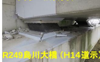
ゴム支承の残留変形
