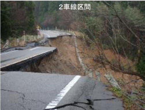
4車線／2車線区間の崩壊事例
