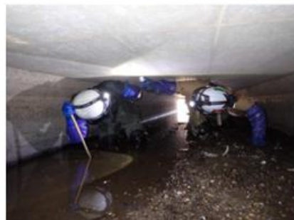
進入困難箇所の近接目視
