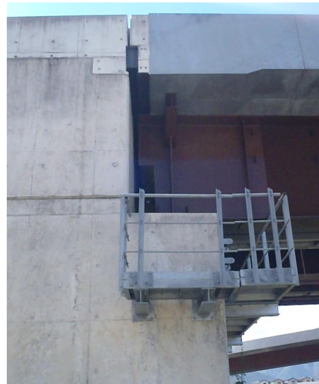
桁端部に切り欠きを設置
