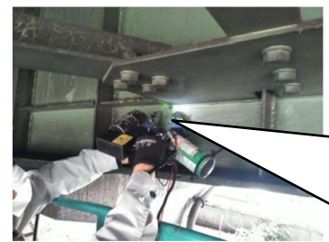
詳細調査状況
