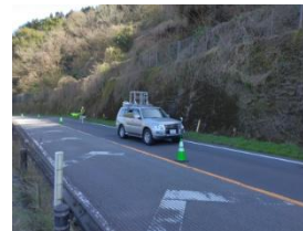
MMS※1を活用した 斜面・のり面点検
