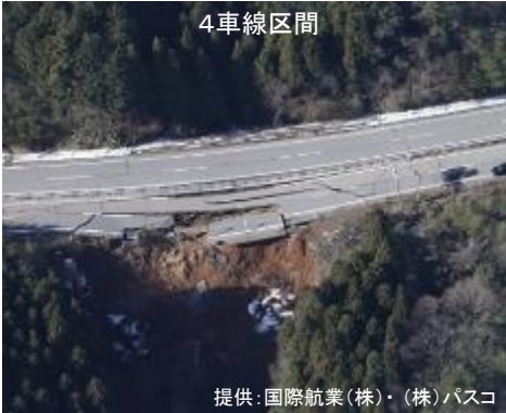
4車線／2車線区間の崩壊事例
