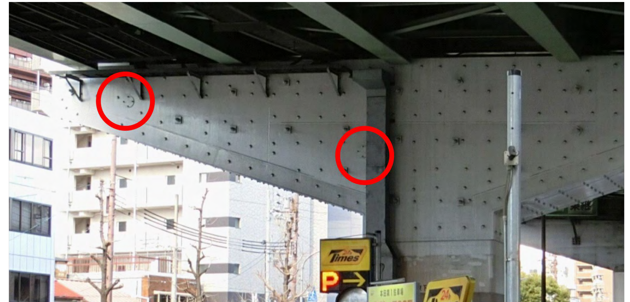
観測窓を設けて定期的な調査を行っている例
