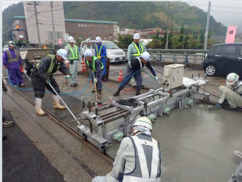
打設・敷均し
