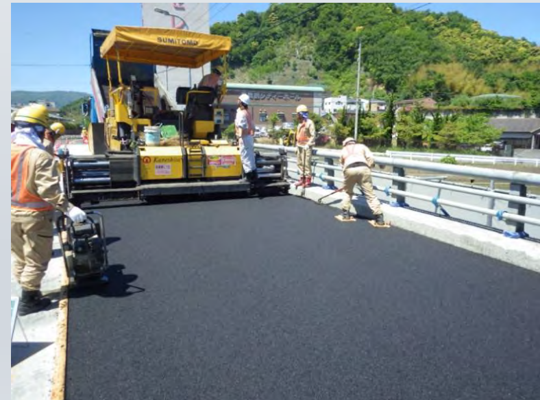
アスファルト舗装
