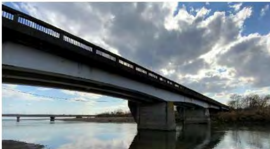
〔白老橋〕 3径間連続RC桁橋2連＋単純PC床版桁橋 橋長 148.2m 幅員7.5m
