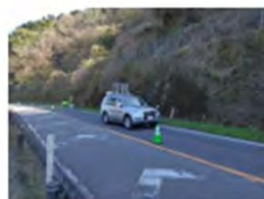
MMS※1を活用した 斜面・のり面点検
