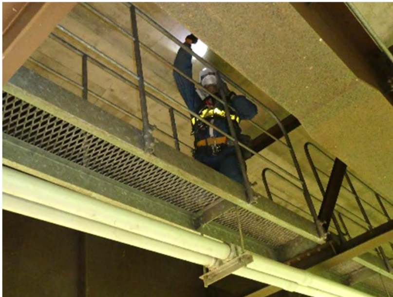
近接目視による橋梁点検
