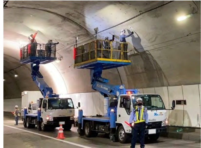
トンネル点検車による点検
