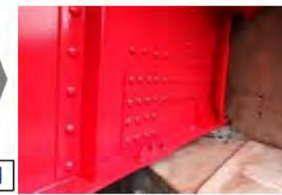
桁端部の当て板・塗装
