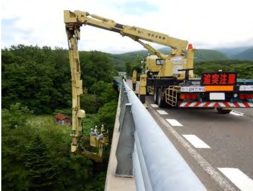
橋梁点検車による点検
