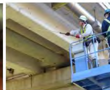
▲ コンクリートのうき・はく離を非破壊で検査する技術
