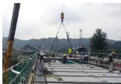
プレキャスト床版による 打ち替え
