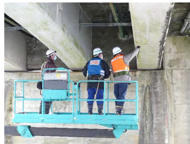
白老町戸田町長(右)に、橋梁の状況を説明
