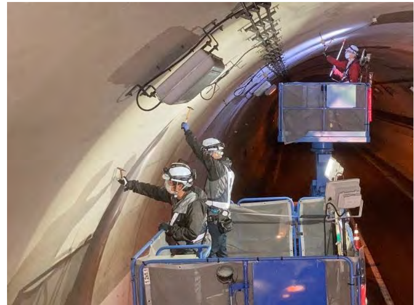
近接目視によるトンネル点検
