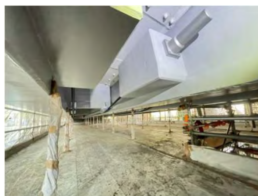
外PCケーブル施工完了
