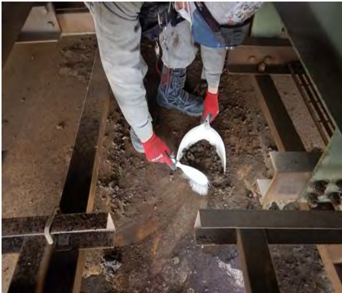
土砂等清掃（橋脚梁上）
