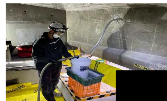
PCケーブルグラウト再注入状況
