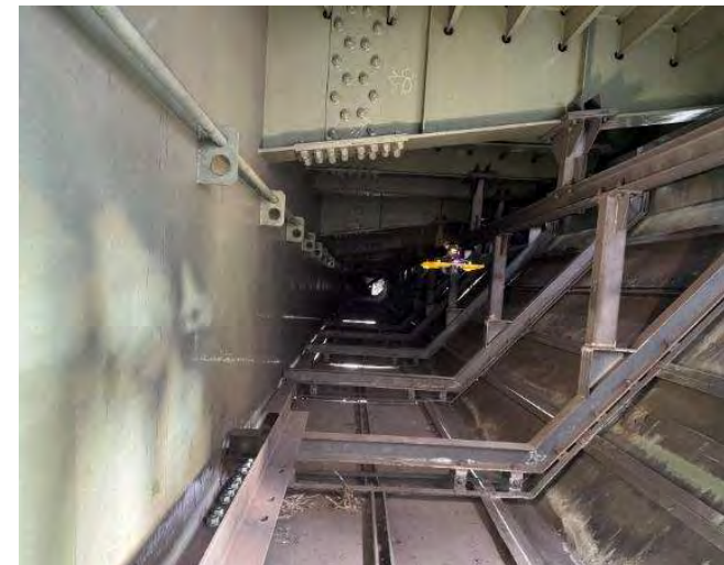
非GNSS環境下における自動運転ドローンの活用（箱桁や内装版内）
