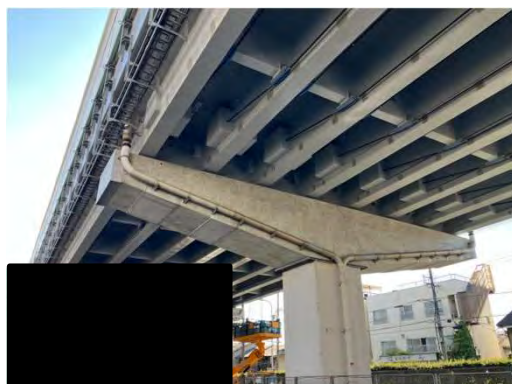
外PCケーブル施工完了
