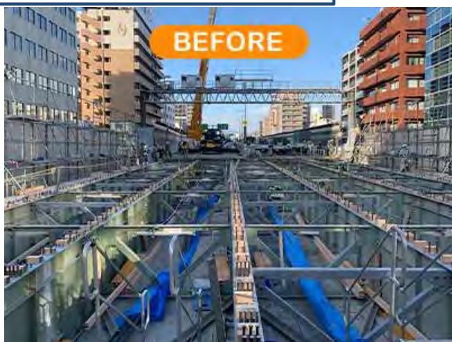
12号守口線 床版取り替え中
