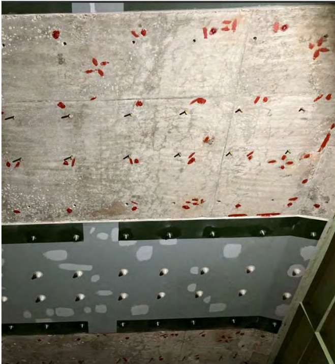
鋼板撤去及び床版状況の確認
