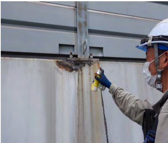
防錆処理（遮音壁支柱基部）
