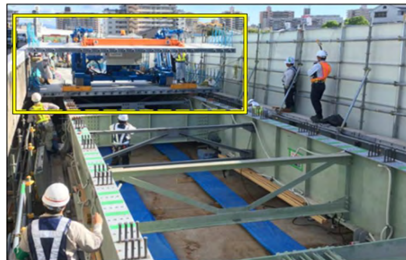
15号堺線玉出入口 床版取り替え状況
