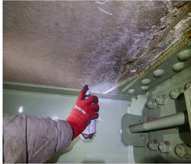
防錆・COはく落防止処理（RC床版）
