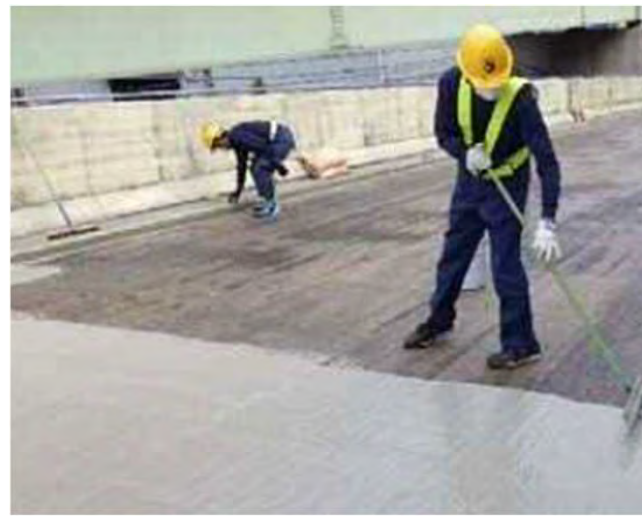
高性能床版防水施工状況
