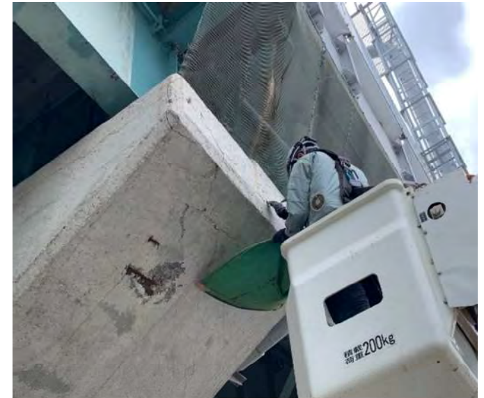
CO片の除去（RC橋脚梁部）
