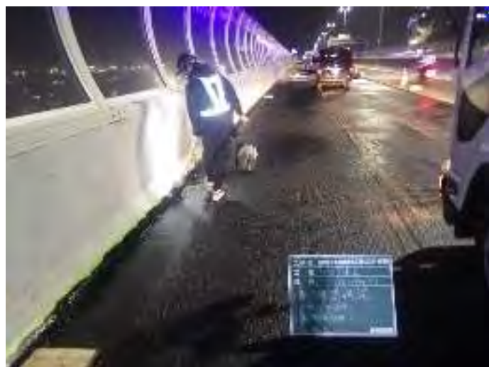
高性能床版防水施工状況
