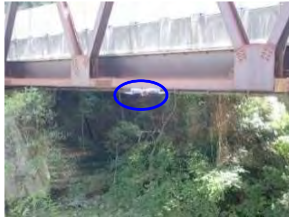
山間部におけるドローン点検（通常）
