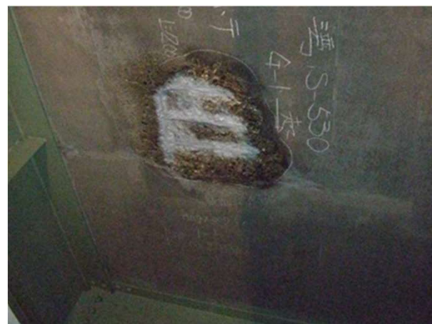
床版防水が施工されていない床版、基準年度が古く、床版厚が薄い床版
