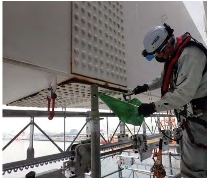
錆片の除去（鋼製橋脚添接部）
