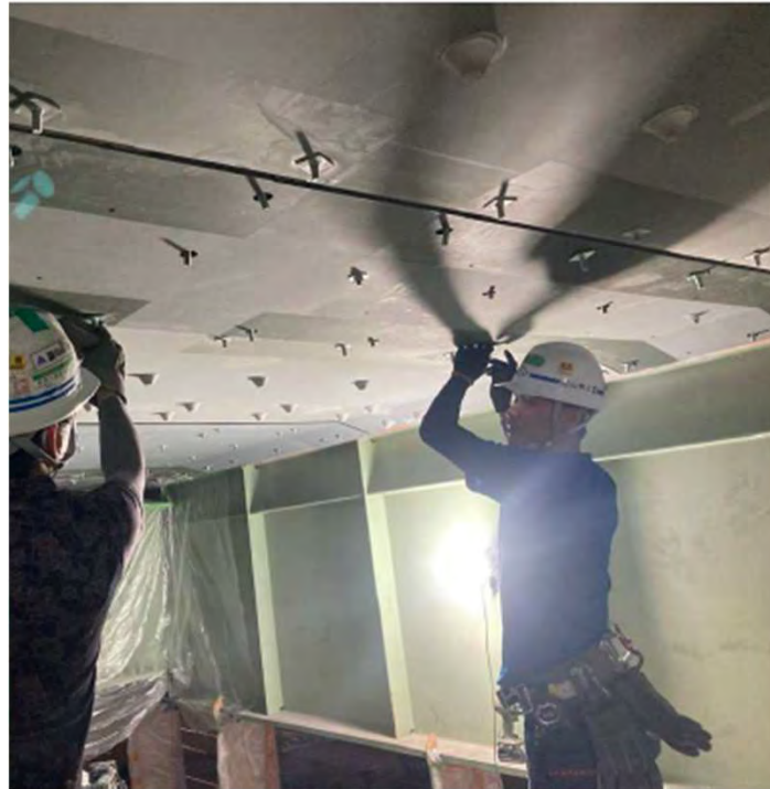
新たな鋼板を設置
