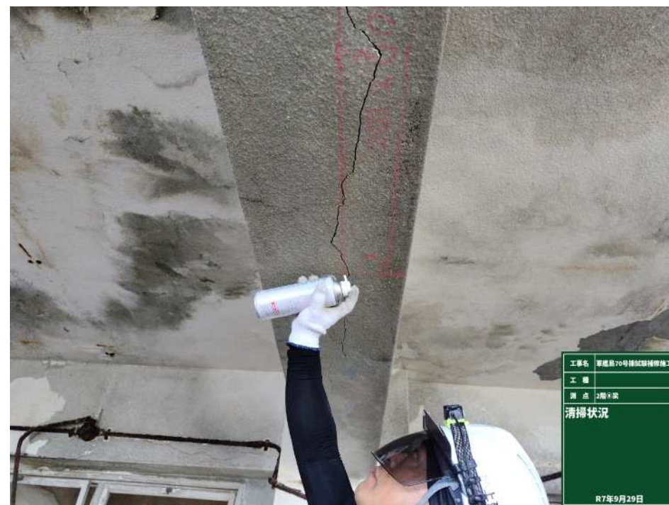
はり下面のひび割れ状況
