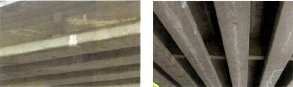
主ケーブルに沿ったひび割れ、エフロレッセンス(左:主桁ウェブ 右:主桁下フランジ)
