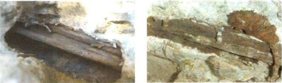
ポストテンションPCT桁橋の主ケーブルで確認された著しい鋼材腐食
