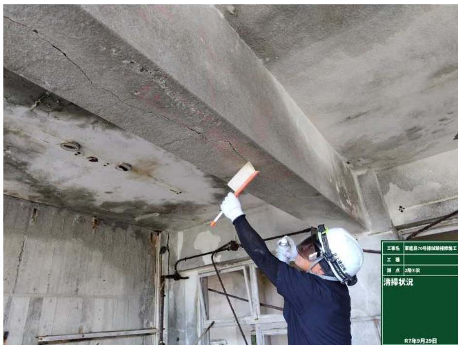
はり下面のひび割れ状況
