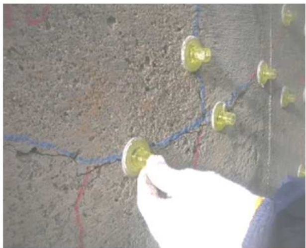
写真 4-2 座金取り付け工の施工状況
