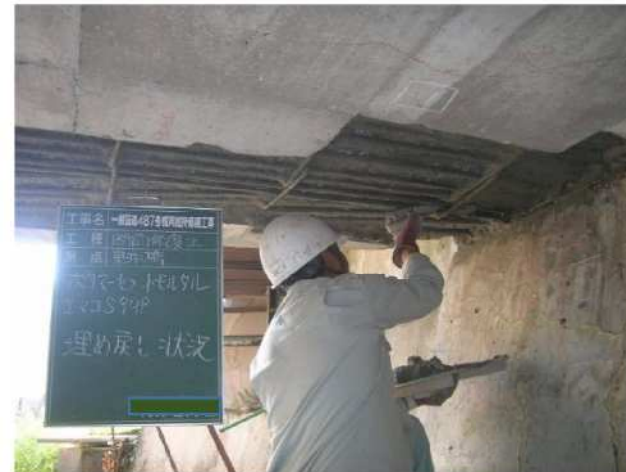
写真 4-5 断面修復状況
