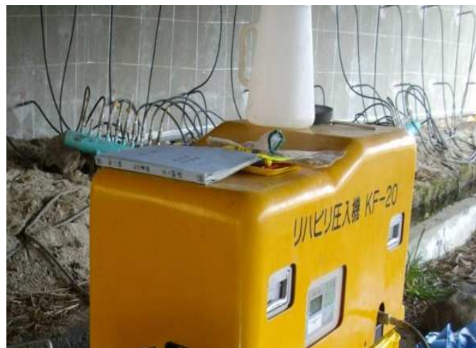
写真 4-6 加圧パッカー装着及び配管状況
