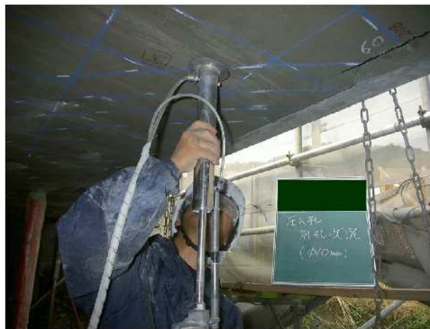
写真 4-5 削孔状況(ダイヤモンドコアドリル)
