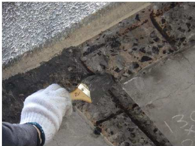
写真 4-4 鉄筋防錆処理状況
