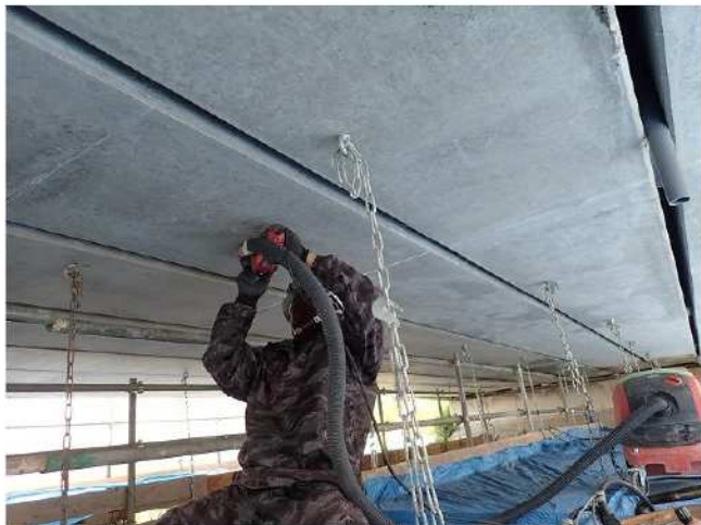
写真 4-1 下地処理工の施工状況
