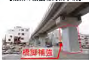
耐震補強例（釜石高架橋）
