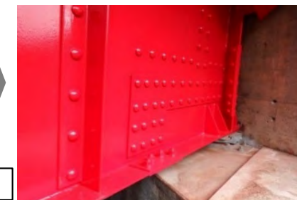
桁端部の当て板・塗装
