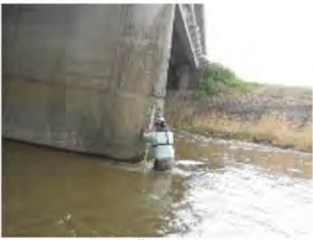
手作業による 下部工洗掘状況の計測
