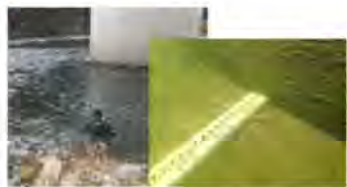
潜水調査による河床洗掘の把握
