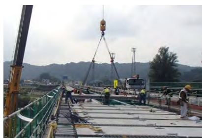
プレキャスト床版による 打ち替え
