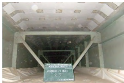
炭素繊維シートの貼り付け
