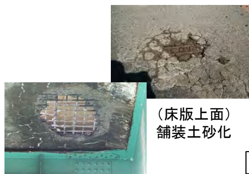
(床版下面) 床版の抜け落ち
