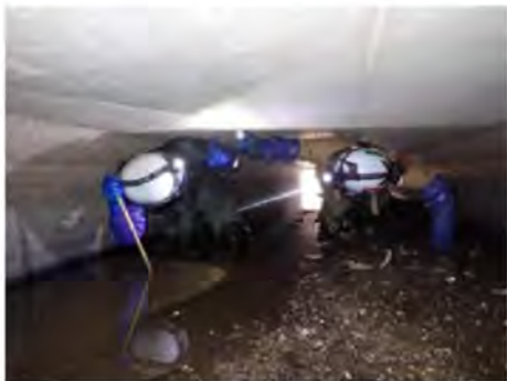
進入困難箇所の近接目視
