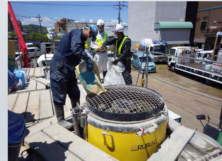
練り混ぜ状況2
