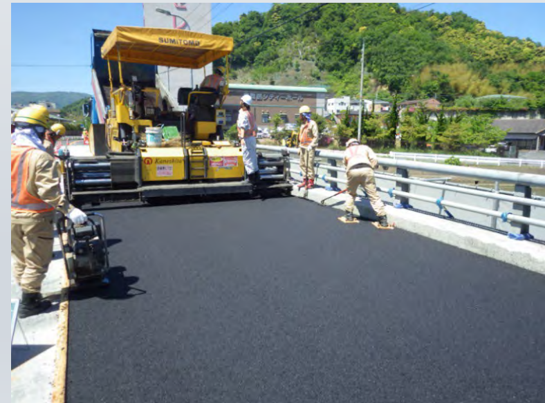
アスファルト舗装
