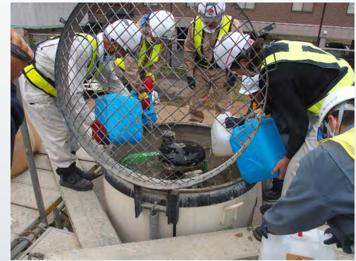
練り混ぜ状況1
