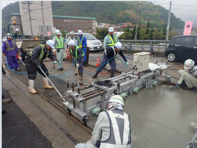
打設・敷均し
