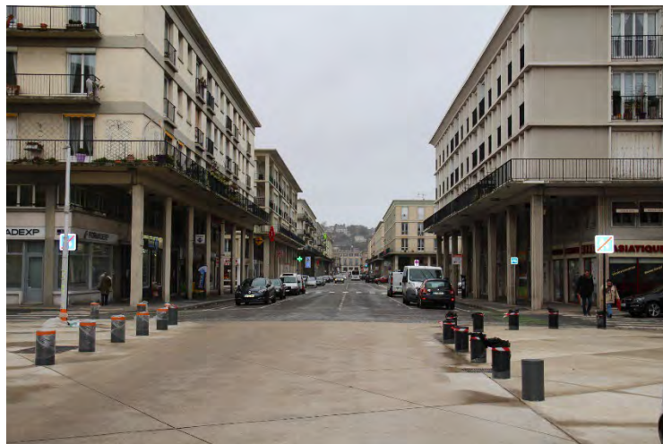
ル・アーブルの再建都市(2005)
