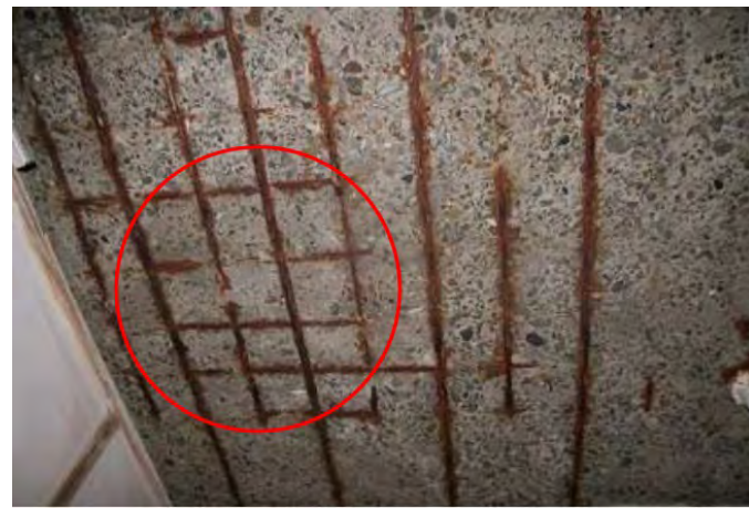
コンクリートの剥落・鉄筋の露出
