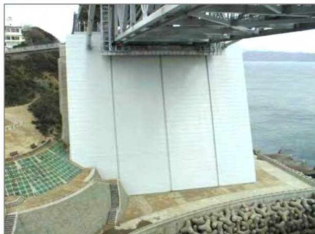
アンカレイジ側面の被覆
