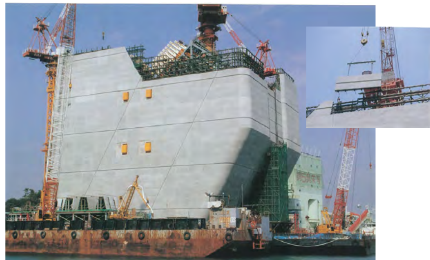
来島海峡大橋4Aアンカレイジ （薄肉Pcaパネル：5cm程度）
