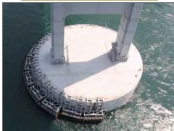
主塔基礎の上面の被覆
