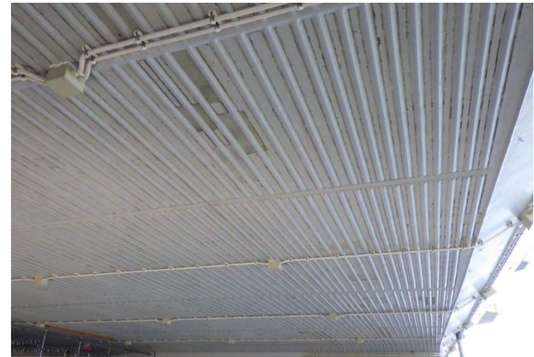
外部電源方式による電気防食 (貼付型線状陽極工法)
