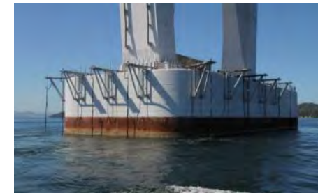
岩黒島橋3P (電着防食)
