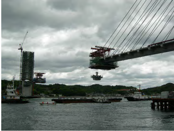
設計施工アドバイス (生名橋)
