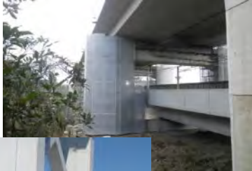
櫃石島高架橋 (耐震補強)
