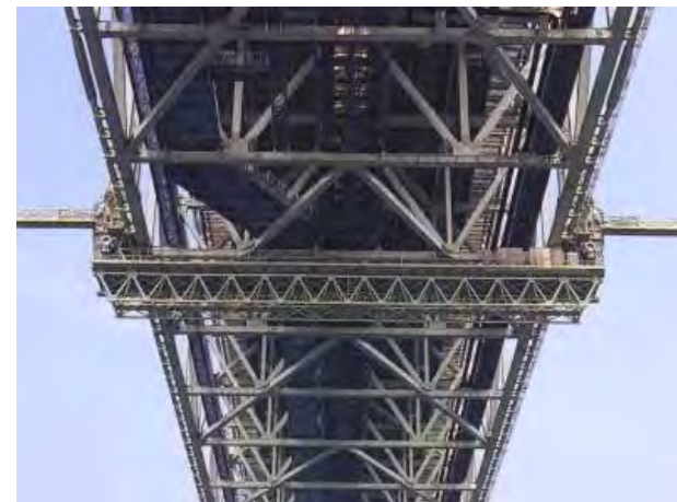
桁外面作業車
