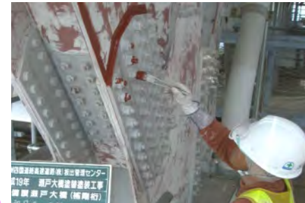
北備讃瀬戸大橋 (補剛桁塗替)
