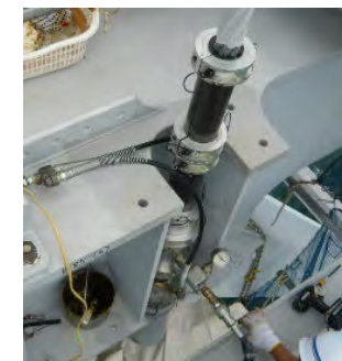
劣化抑制対策の例 (内部充填工法)
