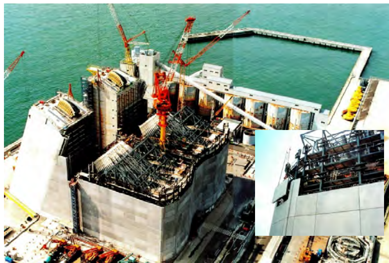
明石海峡大橋1Aアンカレイジ （厚肉Pcaパネル：25cm程度）
