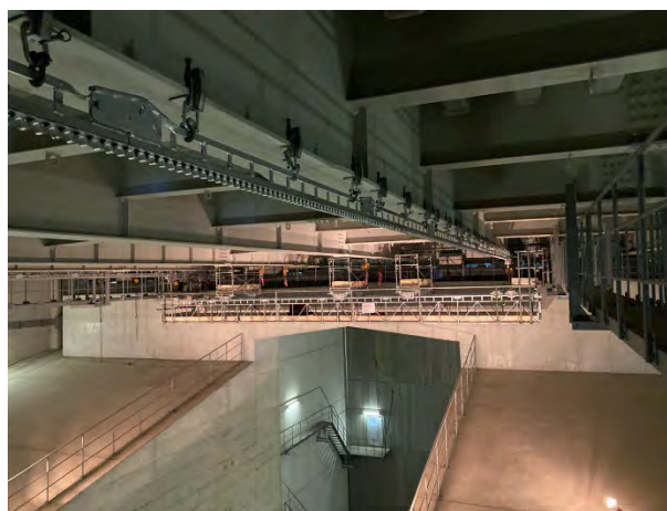
ラック足場(移動式吊足場)
