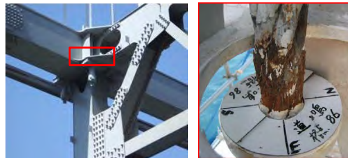
劣化抑制対策の例 (内部充填工法)
