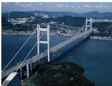
下津井瀬戸大橋
