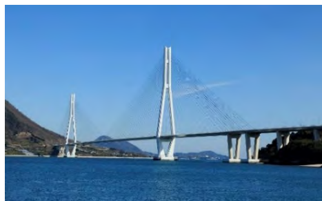
多々羅大橋
