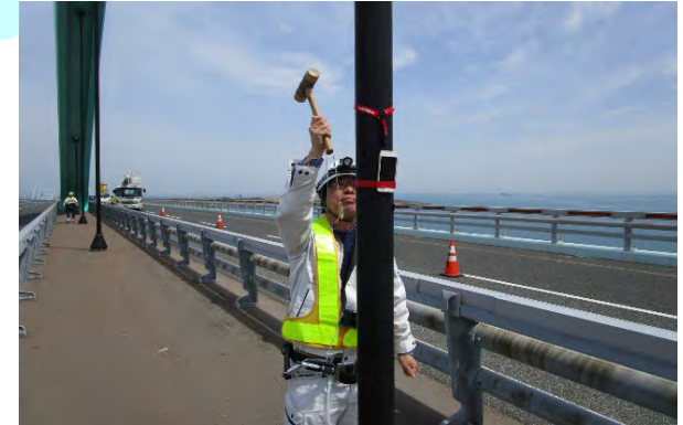
ケーブルの健全性調査 (北九州空港連絡橋)
