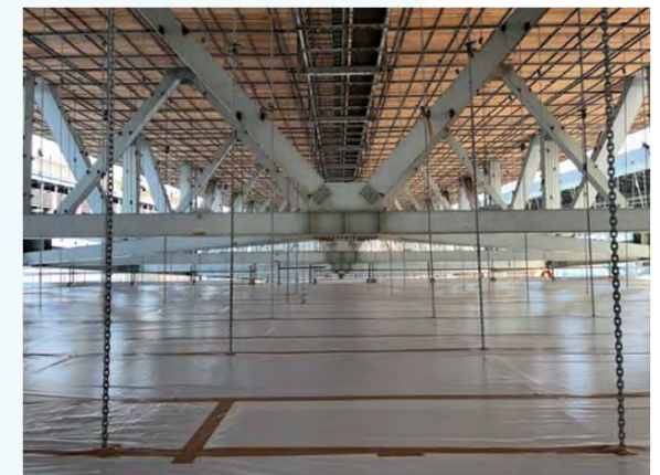
吊り足場(下層)の状況
