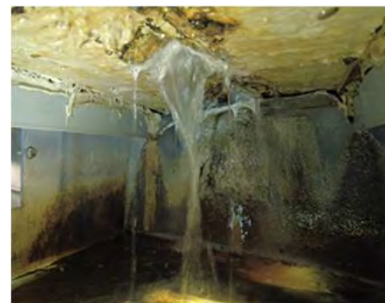
構造目地の漏水
