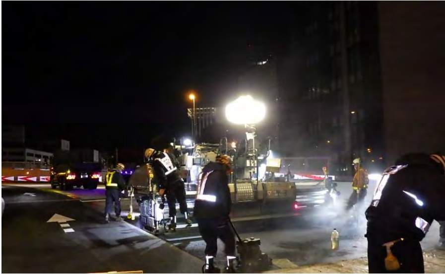
舗装打ち替え
