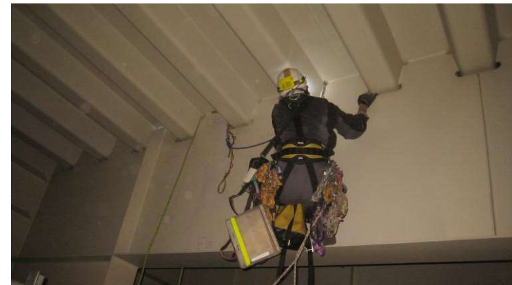
箱桁内での近接点検
