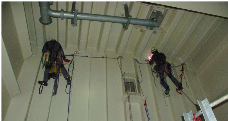
箱桁内での近接点検
