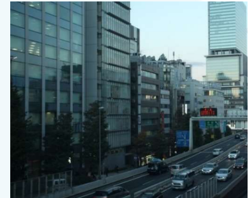
周辺建物と近接
