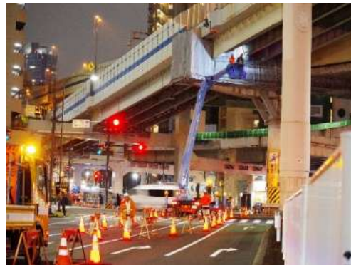
近接点検（街路上）
