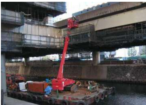
近接点検（河川上）
