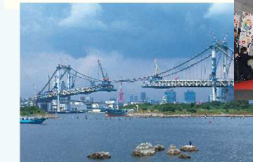
建設中のレインボーブリッジ
