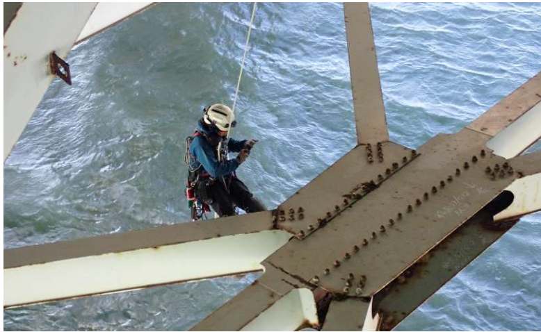
高架下に車両が入れない箇所での近接点検
