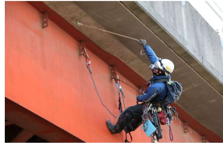
高架下に車両が入れない箇所での近接点検
