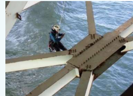
近接点検（ロープによるアクセス）
