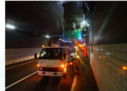
近接点検（トンネル内）
