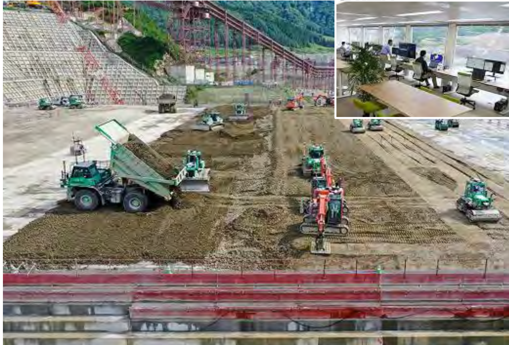
A 4 CSELの自動化建設機械が連携して堤体打設を行う様子
