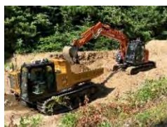
自動施工の高度化
