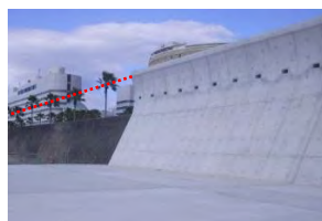
海岸保全施設整備
