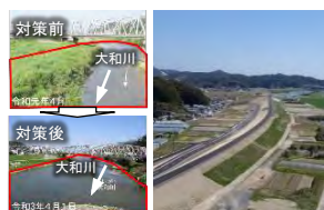
河道掘削・堤防整備
