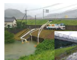
災害対策用車両の整備 (排水ポンプ車)
