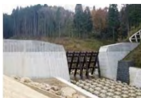
砂防関係施設整備
