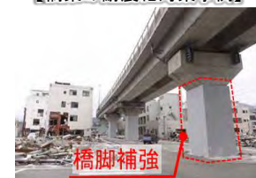
耐震補強例(釜石高架橋)
