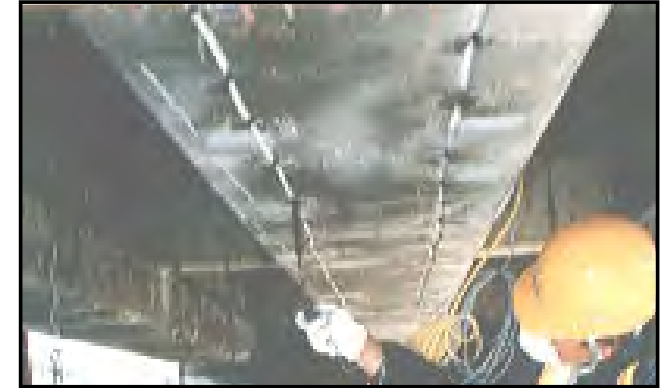
チタンロッド挿入工法
