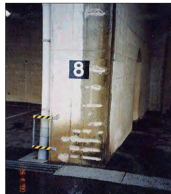
桁受け部の柱
