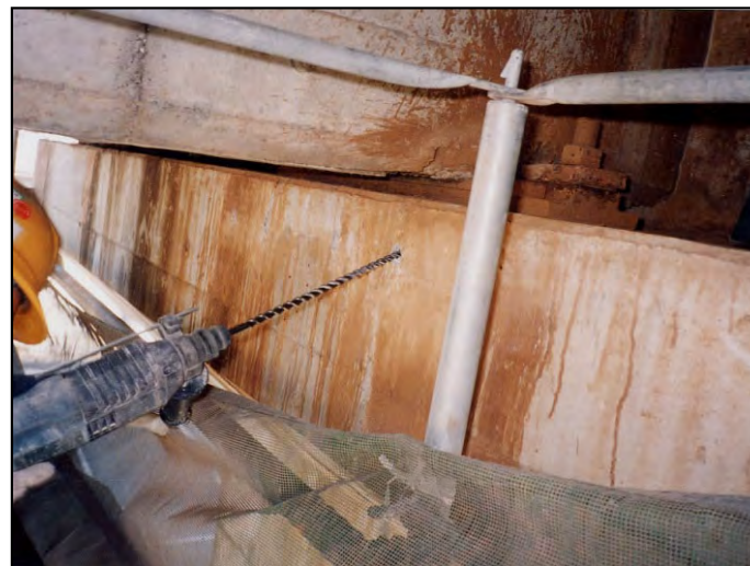
桁座補修 削孔
