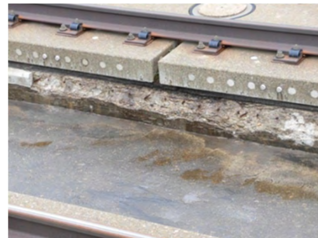
[路盤コンクリート]
