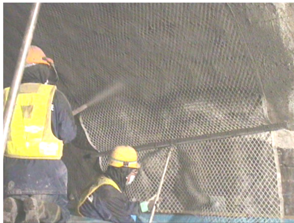
SANショット工法
