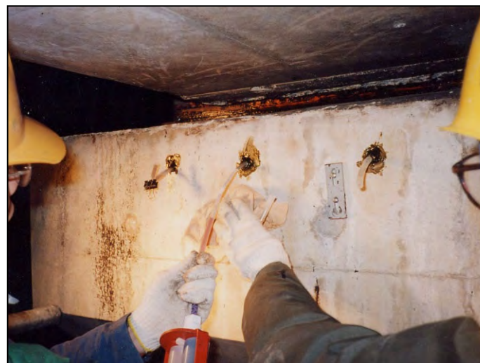
アクリル樹脂注入
