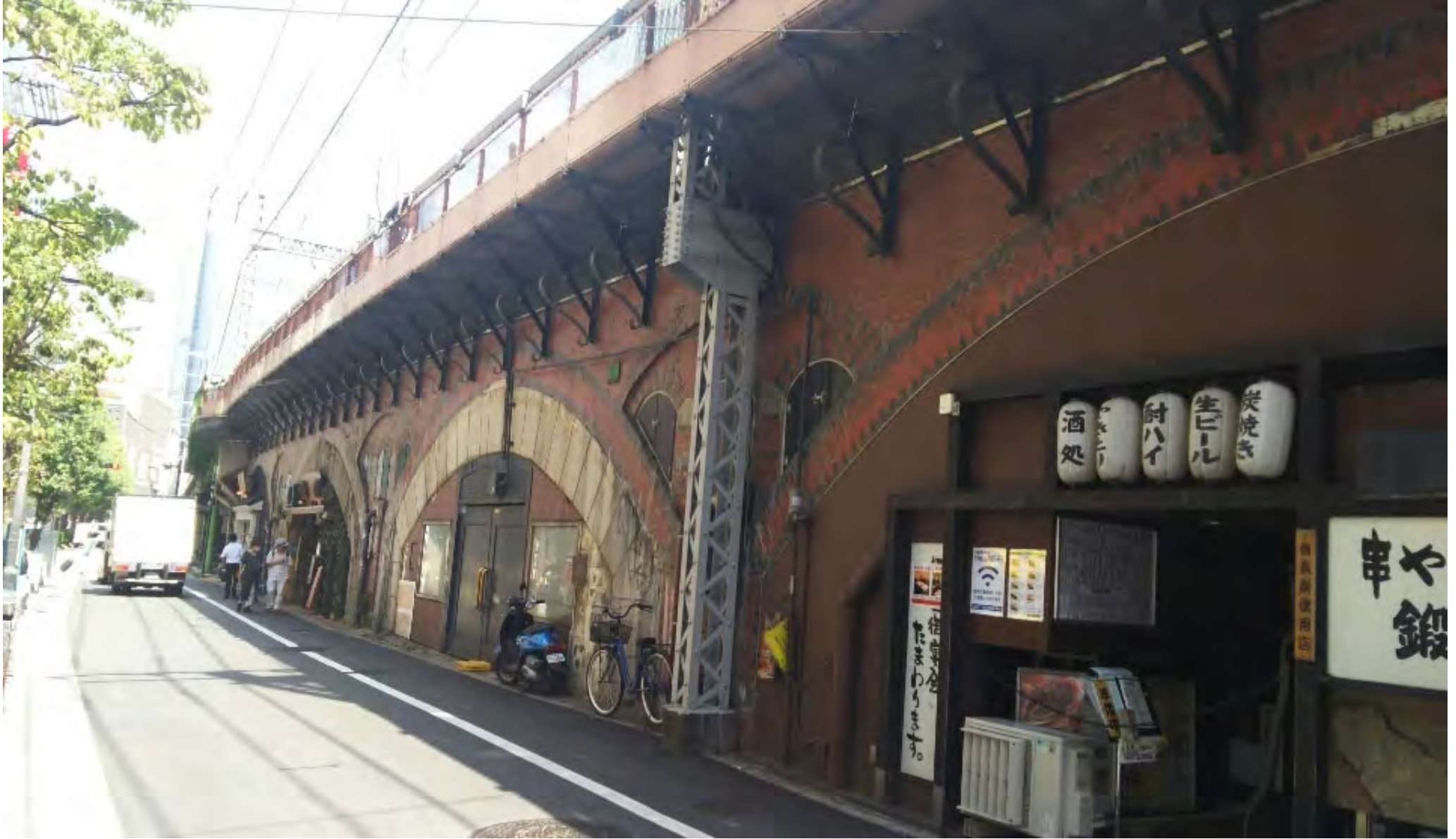
JR 東京ー新橋レンガアーチ高架橋 1910年（ 経年115年 ）
