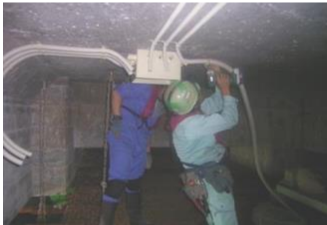
⑦配線配管工配線配管
