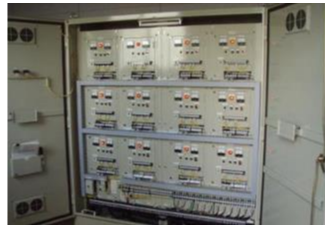
⑧直流電源設置工:電源設置,電流調整
