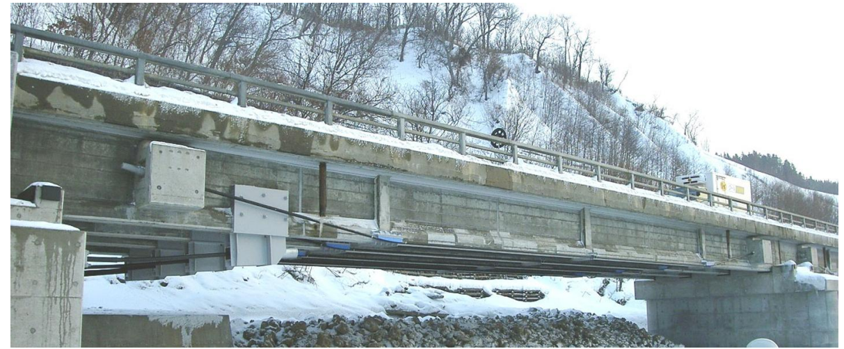
線状陽極による電気防食＋外ケーブル補強 (リボンメッシュ)
