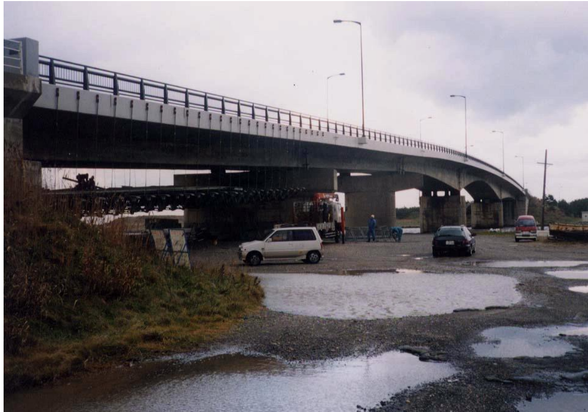
面状陽極による電気防食を適用したPC箱桁橋 (チタンメッシュ)
