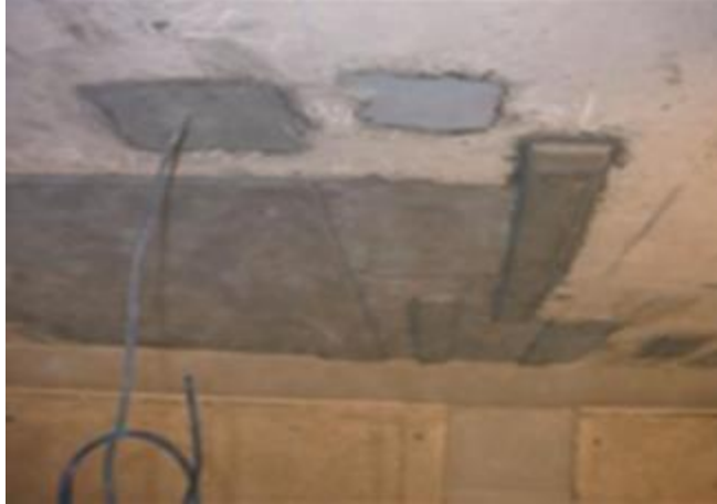
⑤モニタリング装置設置工はつり部復旧
