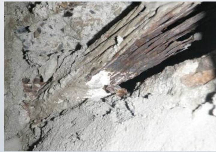
PCマルチストランド 主桁
