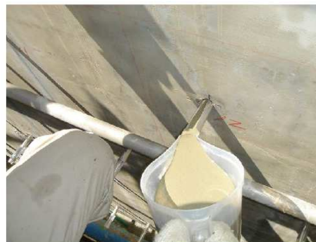
写真 4-7 圧入孔充填状況
