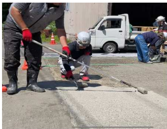
写真 4-4 表面補修・不陸修正材(厚塗り仕様 2層目)塗布工の施工状況 (左:砂骨ローラーでの施工 右:金鋏での施工)
