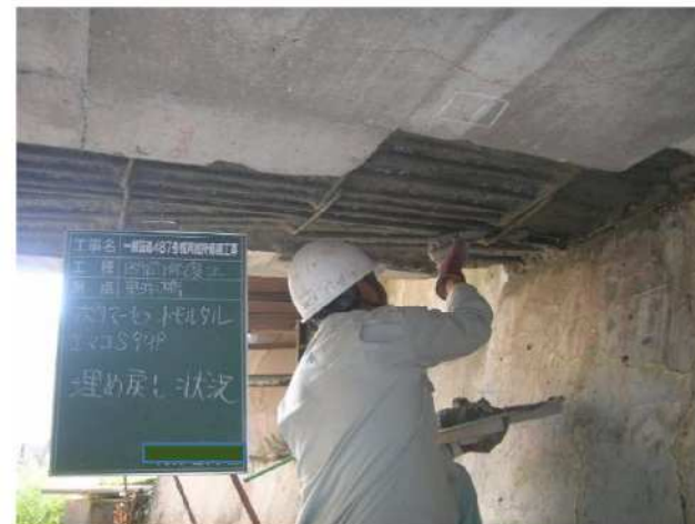
写真 4-5 断面修復状況
