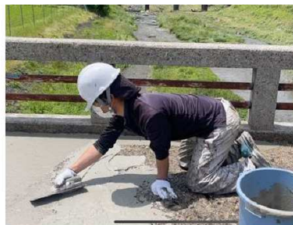
写真 4-4 表面補修・不陸修正材(厚塗り仕様 2層目)塗布工の施工状況 (左:砂骨ローラーでの施工 右:金鋏での施工)
