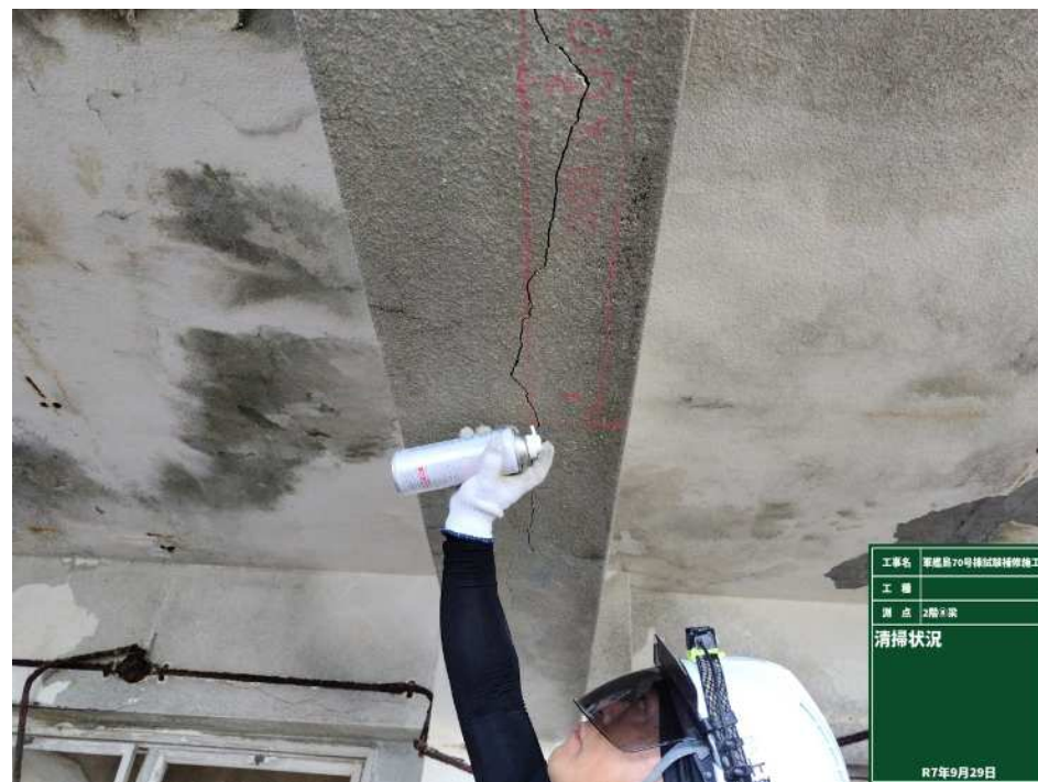
はり下面のひび割れ状況
