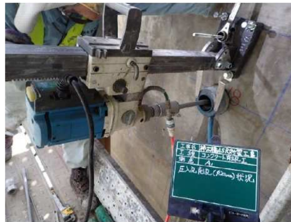
写真 4-5 削孔状況(ダイヤモンドコアドリル)
