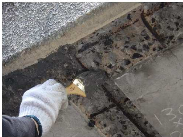
写真 4-4 鉄筋防錆処理状況
