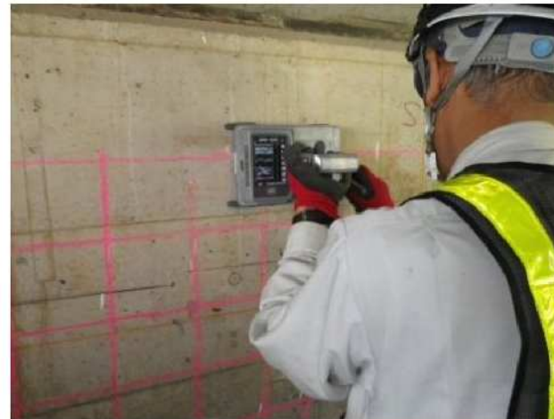
写真 4-4 鉄筋探査状況
