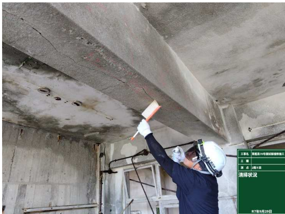
はり下面のひび割れ状況
