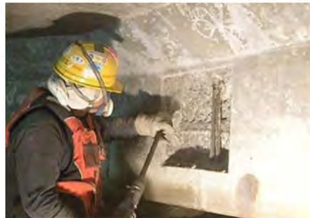
②モニタリング装置設置工端子取付部はつり
