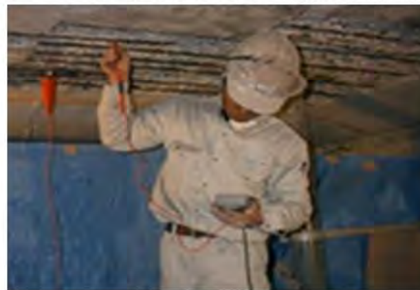
④モニタリング装置設置工鉄筋間導通確認
