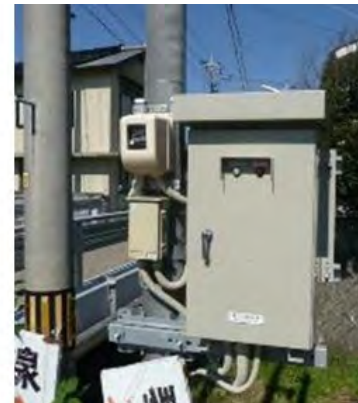
直流電源装置の設置例
