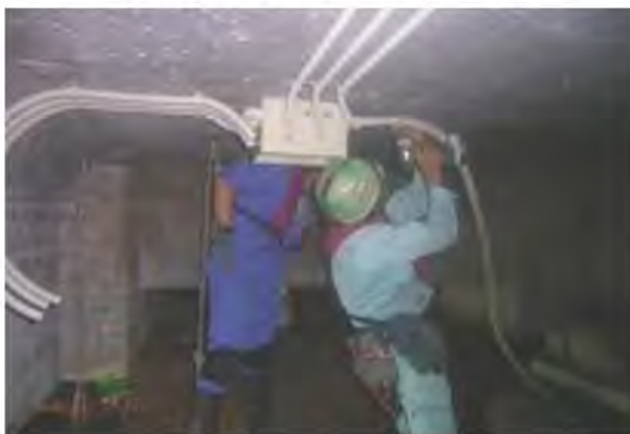
⑦配線配管工配線配管
