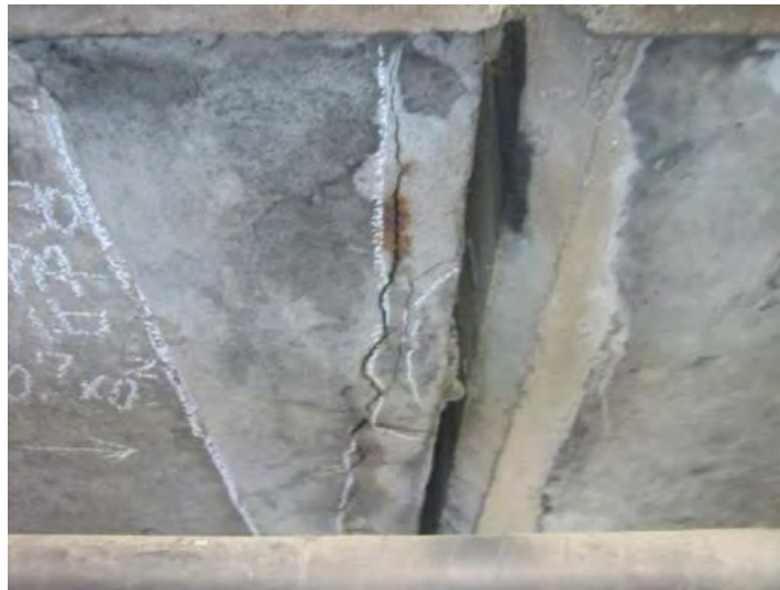
断面修復部(塩害対策)
