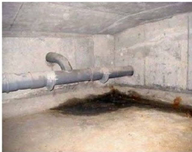
排水管漏水状況
