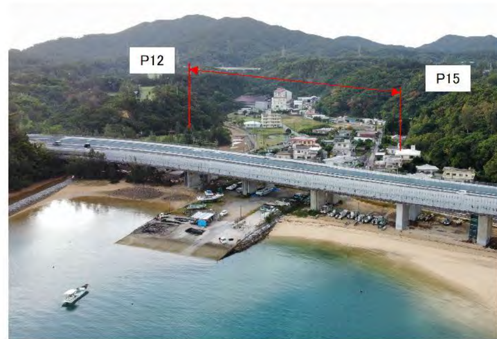
【現場状況写真】
