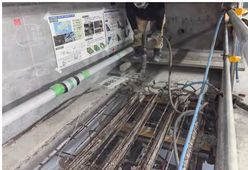
部材②撤去
