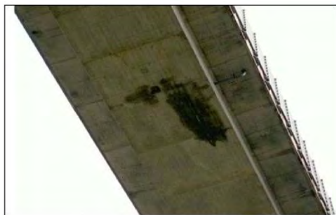
排水管漏水状況
