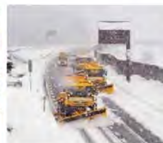
除雪作業状況
