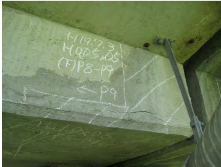
断面修復部(塩害対策)
