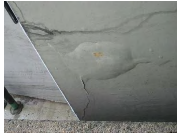
コンクリート塗装部
