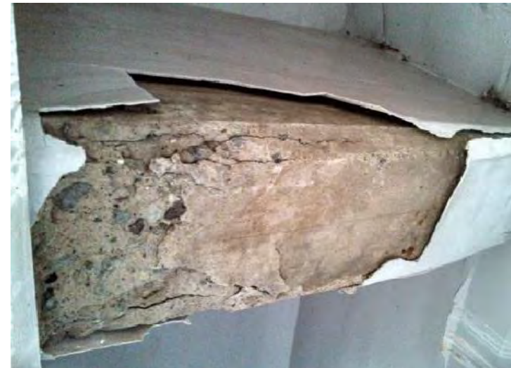
コンクリート塗装部
