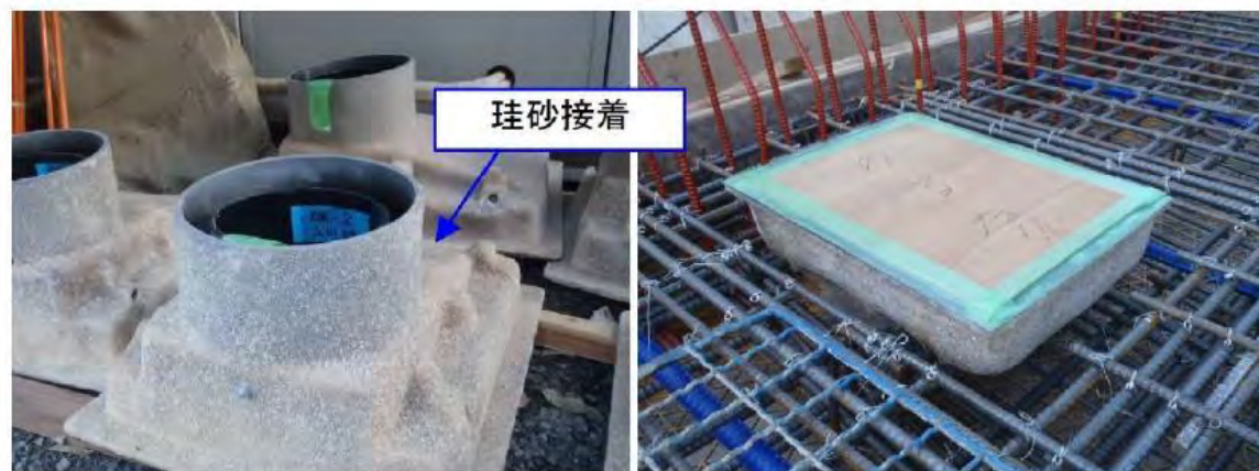
排水桷の表面に珪砂を接着しコンクリートとの付着性向上
