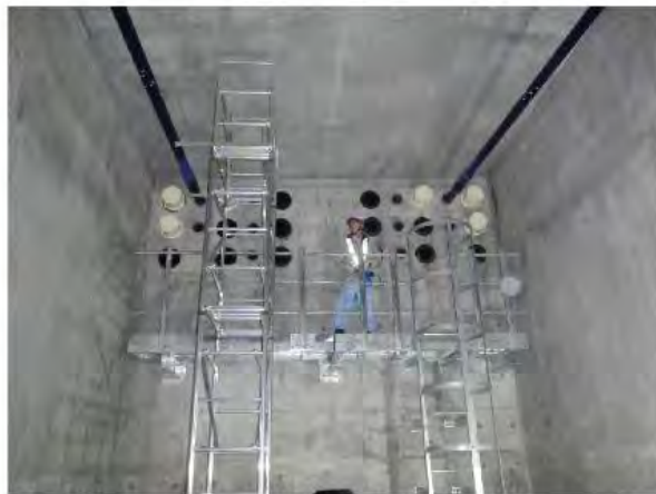
支点部の固定点検足場
