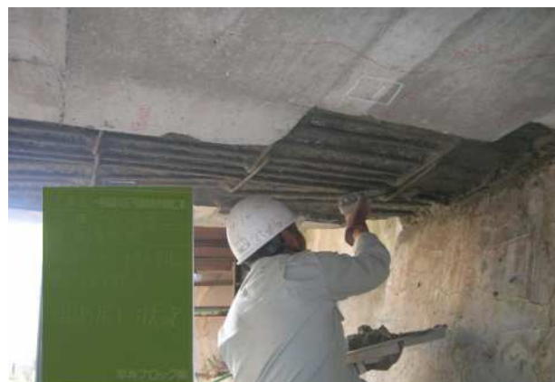
部分断面修復工
