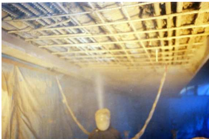
全断面修復工法
