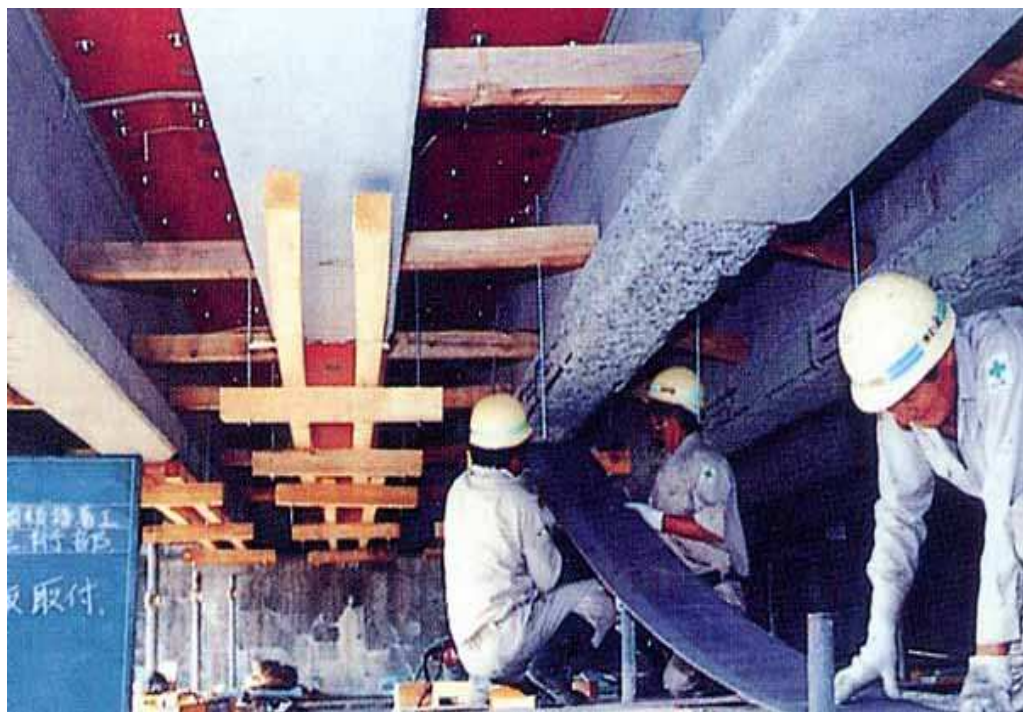
鋼板接着工法
