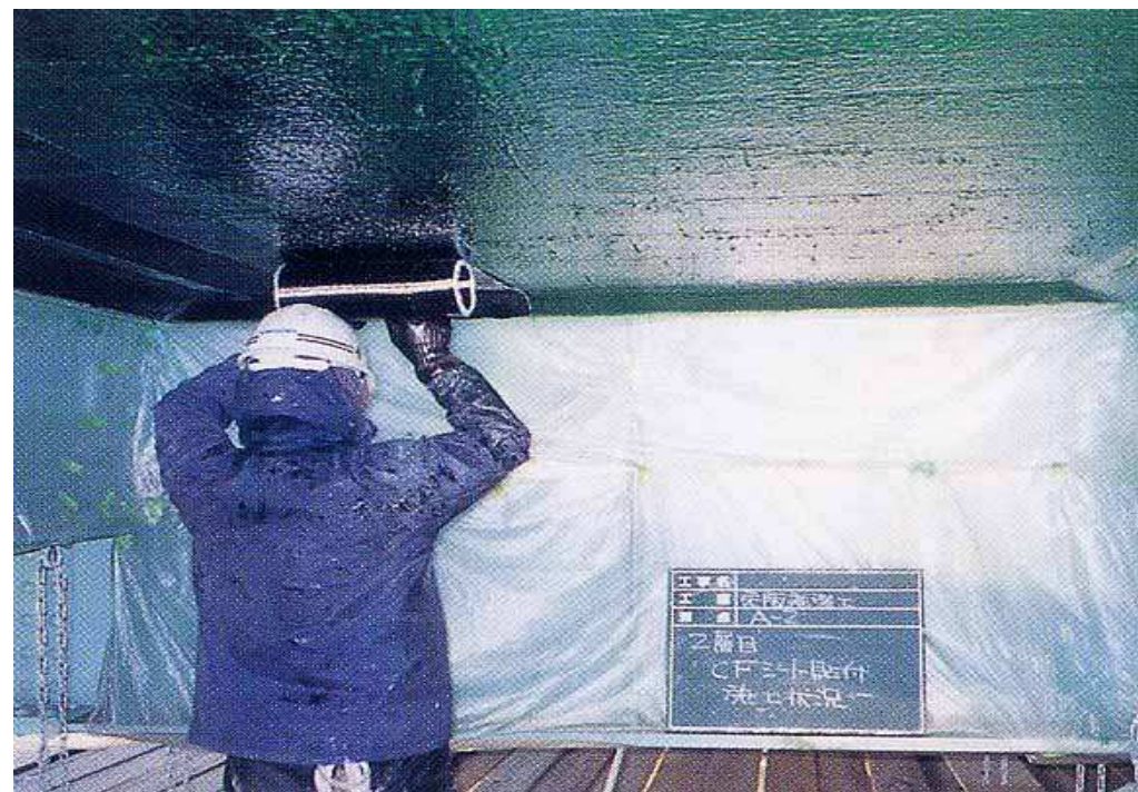
連続繊維シート接着工法
