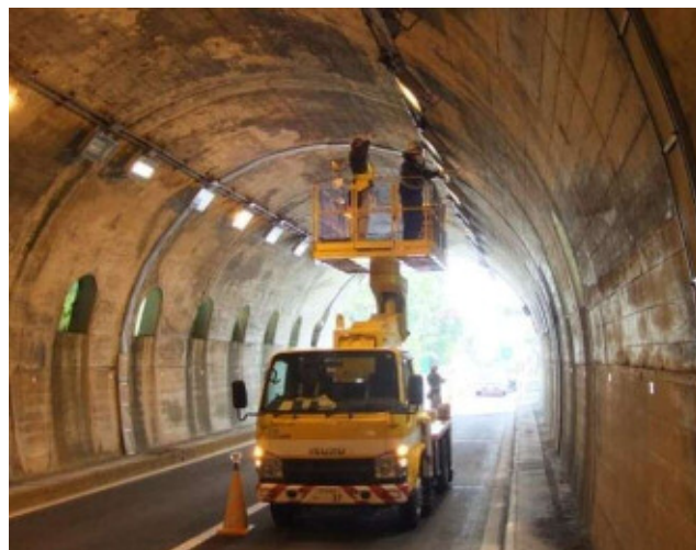
写真 橋梁点検車およびトンネル点検車
