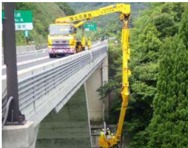
写真 橋梁点検車およびトンネル点検車
