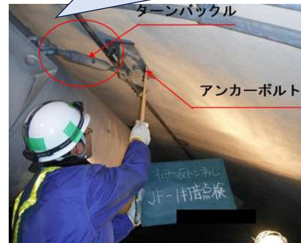
写真 近接目視点検・打音検査状況
