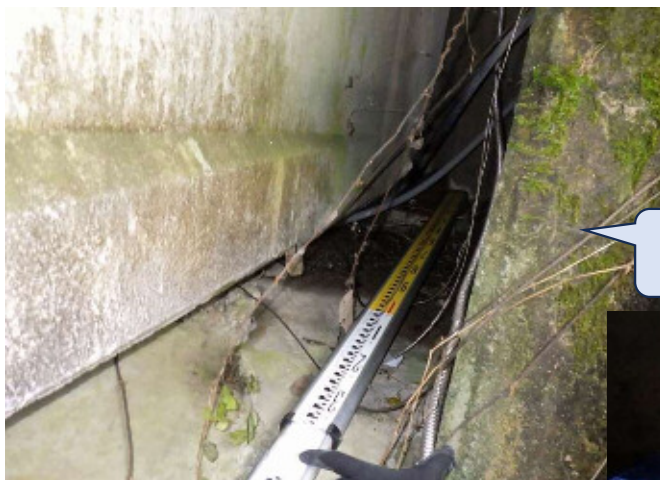
写真 土留め壁と主桁の間
