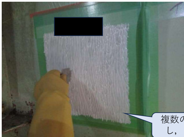
写真 塗膜剥離剤の試験施工 ひびわれ注入工詳細図
