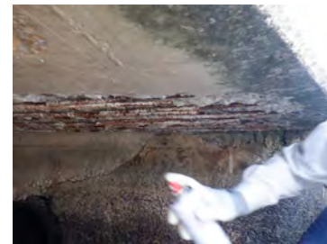
＜防錆剤・プライマー塗布＞
