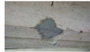
小規模箇所の断面修復
