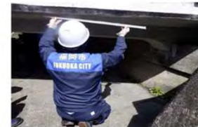
水切り板の設置
