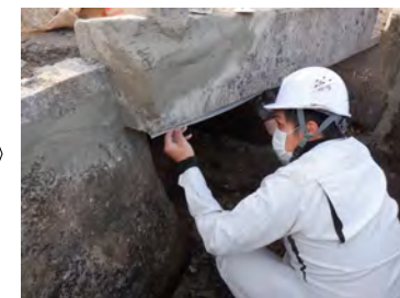
＜水切り設置 施工状況＞
