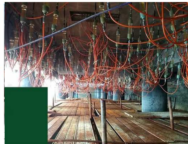
写真 4-6 リハビリカプセル設置状況
