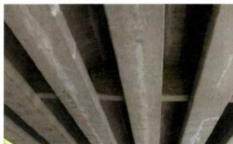
主ケーブルに沿ったひび割れ、エフロレッセンス(左:主桁ウェブ 右:主桁下フランジ)
