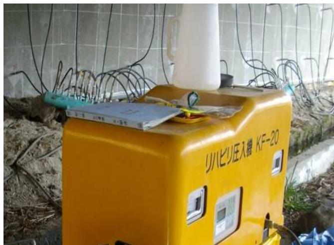
写真 4-6 加圧パッカー装着及び配管状況
