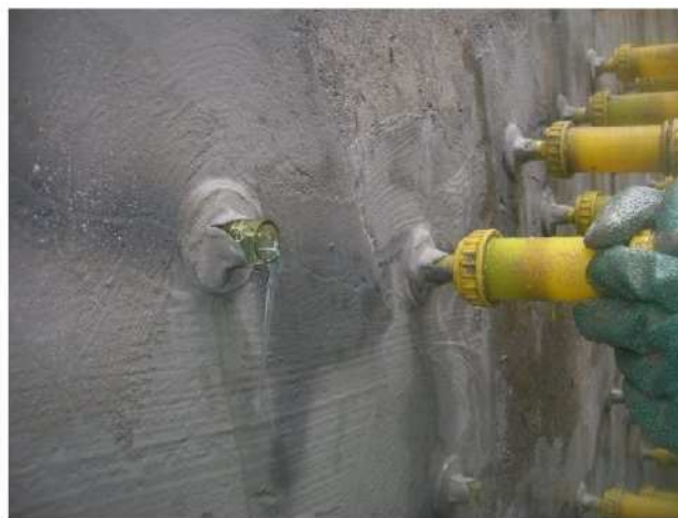
写真 4-4 浸透拡散型亜硝酸リチウム先行注入の施工状況
