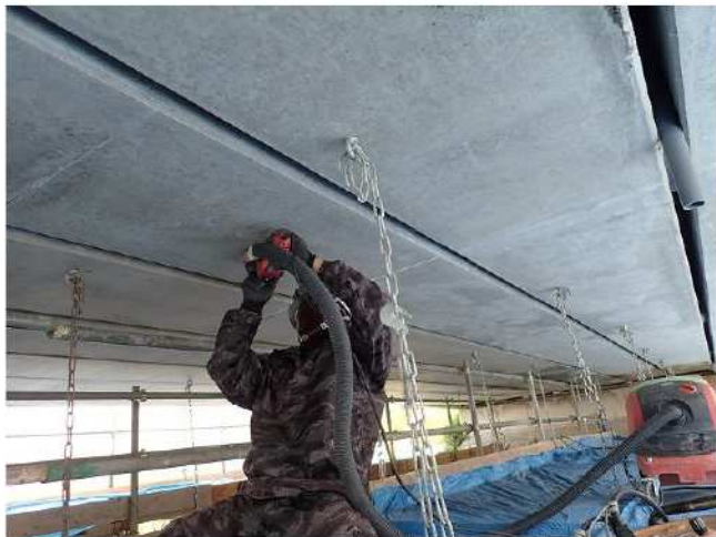
写真 4-1 下地処理工の施工状況
