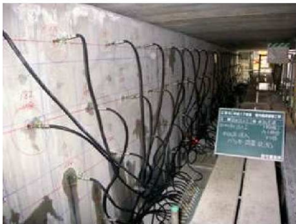
写真 4-6 加圧パッカー装着及び配管状況
