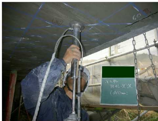
写真 4-5 削孔状況(ダイヤモンドコアドリル)
