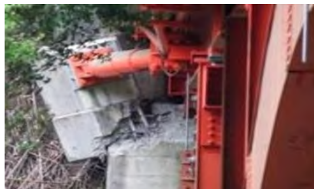
上下部接続部(支承部, 変位制限装置, 減衰付加装置など)の損傷
