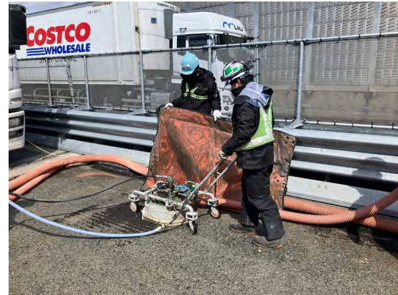
WJ表面処理施工
