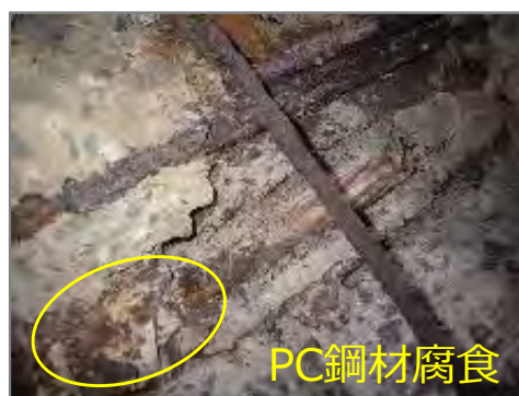
下床版 上面の損傷状況
