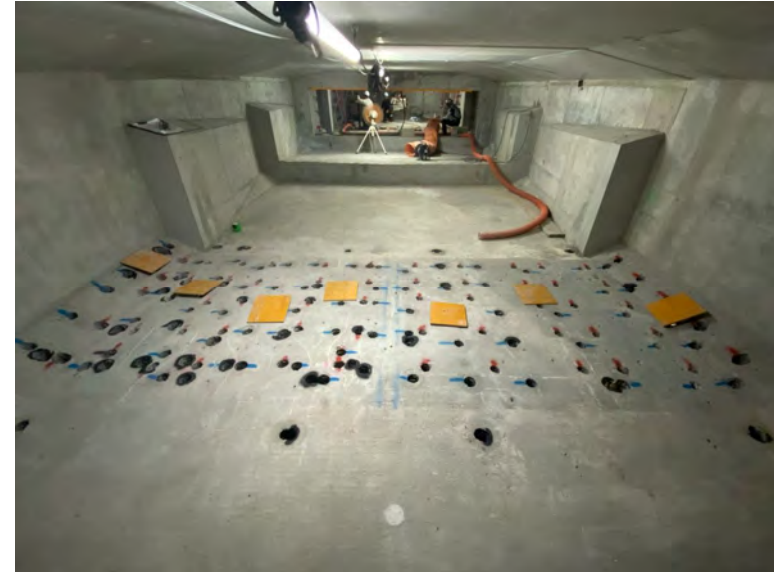
定着突起（削孔）
