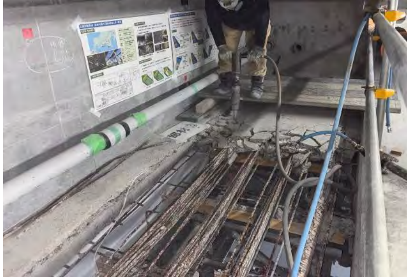
部材②撤去（ブレイカー）
