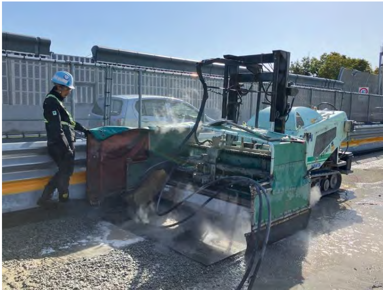
WJはつり施工
