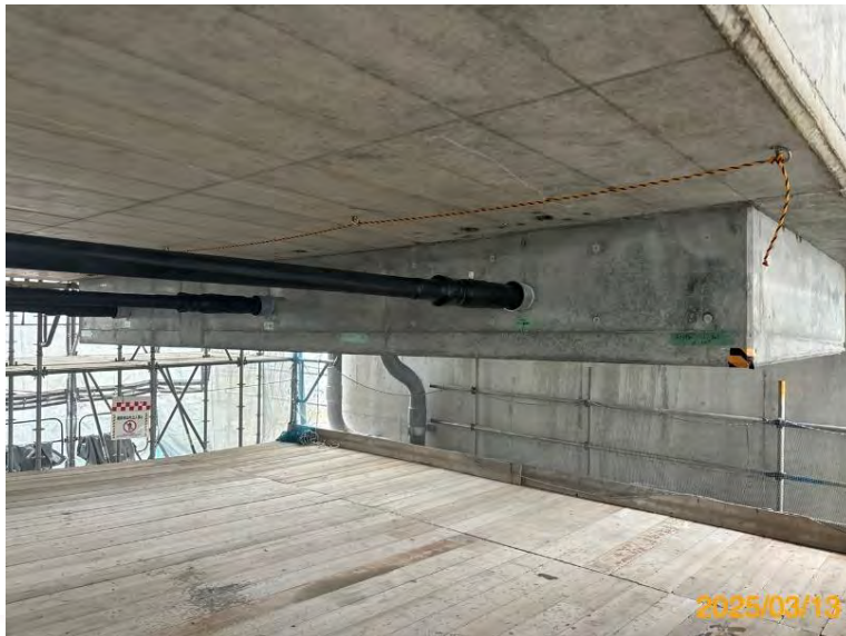
みち、ひと…未来へ。 NEXCO 定着突起（桁外） 西日本
