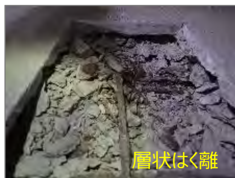
下床版 上面の損傷状況
