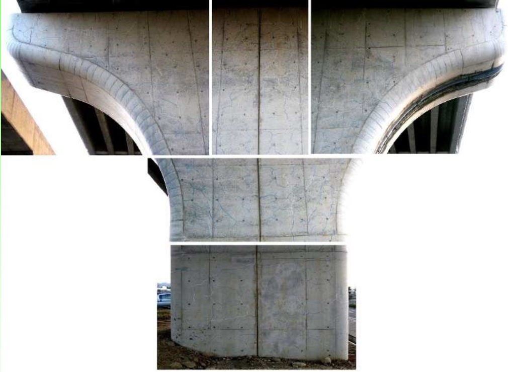
●自然田高架橋 橋脚
