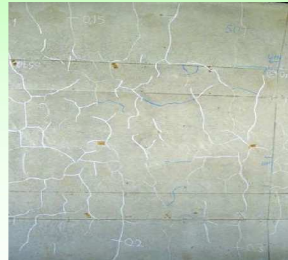
●菟砥川高架橋 プレベーム床版下面
