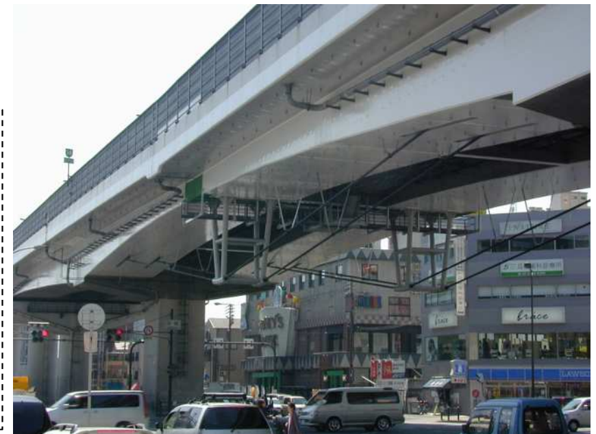
【下弦ケーブル補強の状況】
