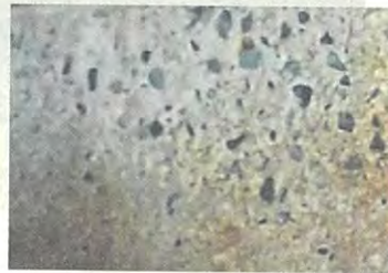
写真2 粗骨材の露出状況
