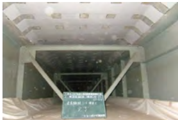
炭素繊維シートの貼り付け
