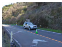
MMS※1を活用した 斜面・のり面点検
