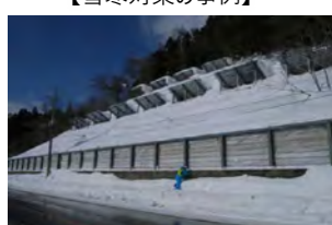
雪崩対策の例（雪崩防止柵）
