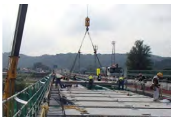
プレキャスト床版による 打ち替え
