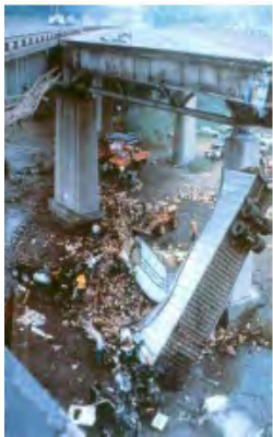
マイアス橋の崩壊（1983年）
