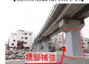
耐震補強例（金石高架橋）
