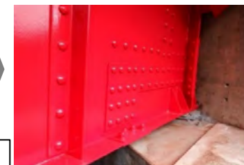
桁端部の当て板・塗装
