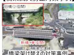
橋梁架け替えの対策事例
