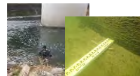
潜水調査による河床洗掘の把握
