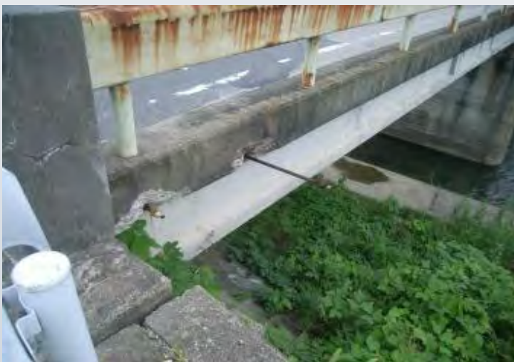
PC鋼棒 床版横締
