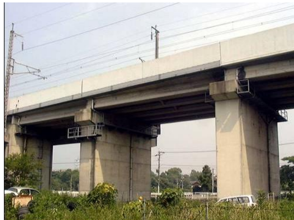
鉄筋コンクリート (RC) 桁
