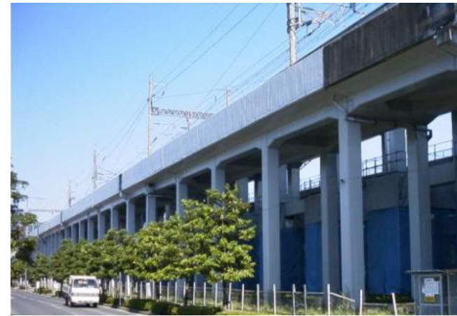
鉄筋コンクリート (RC) ラーメン高架橋
