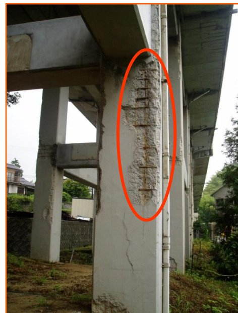
左上：高架橋スラブ下面 左下：高欄 右：高架橋柱
