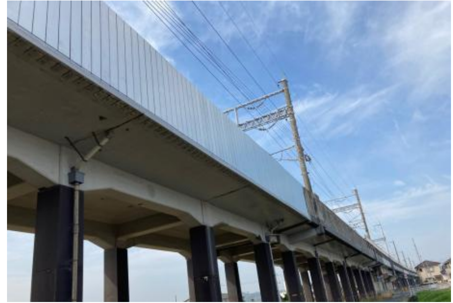
支柱を設けない新型高欄の外観
