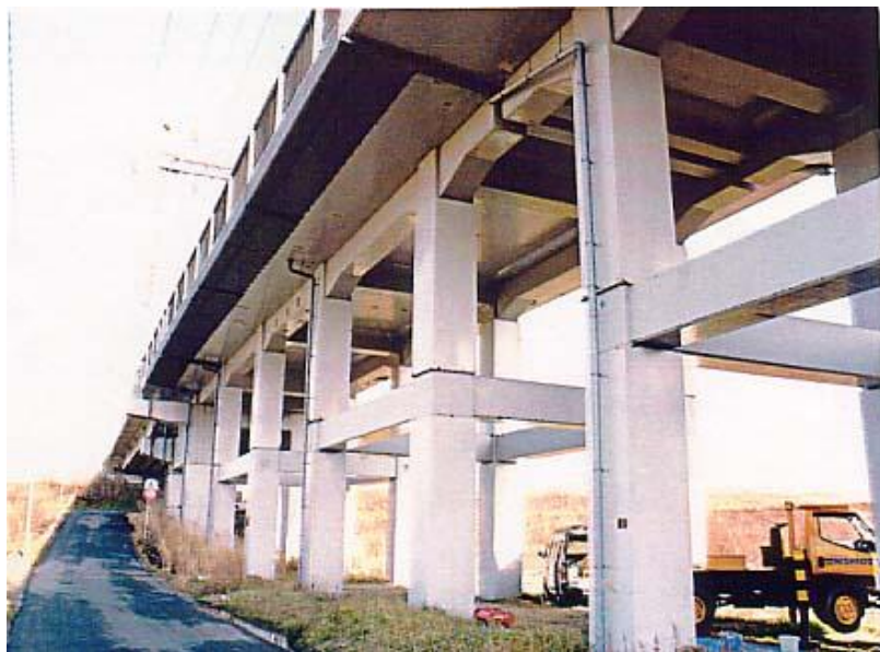
ラーメン高架橋での実施状況
