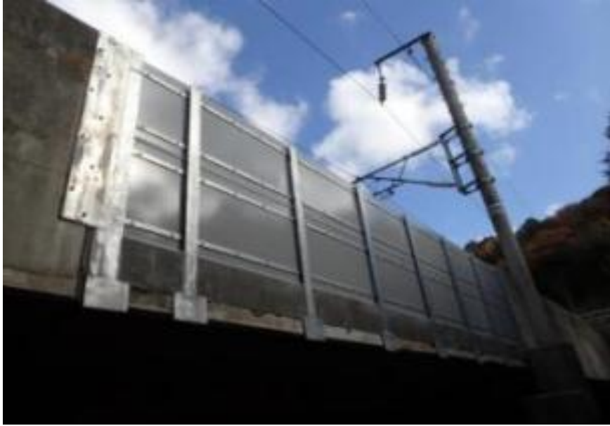
支柱を設ける取替高欄の外観
