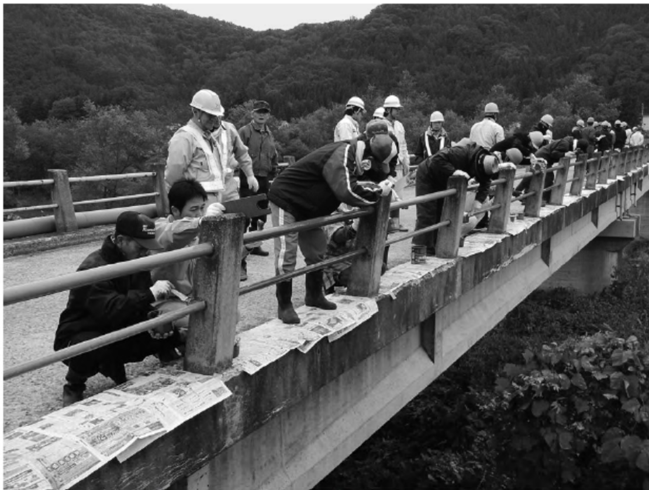
住民との協働による橋の欄干塗装の様子（筆者撮影）
