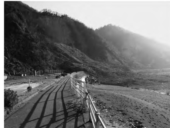
大規模な斜面崩壊（能登半島地震）（筆者撮影）
