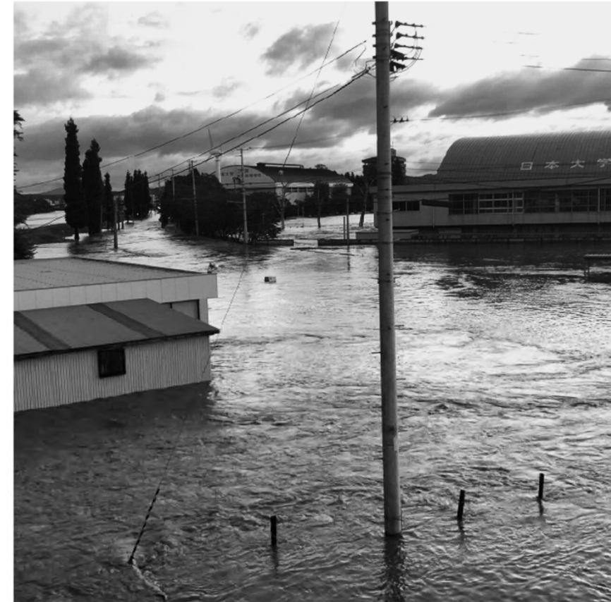
被災した日本大学工学部キャンパス（令和元年東日本台風）
