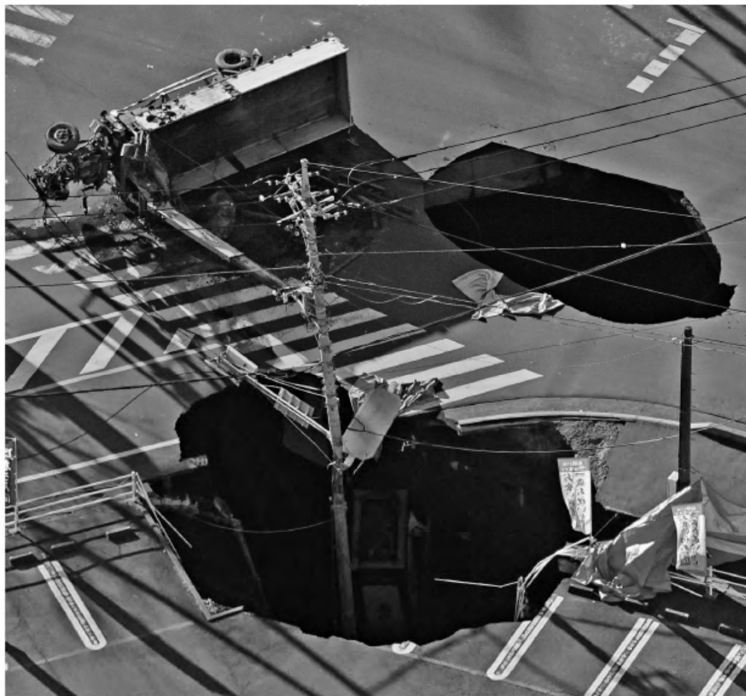
埼玉県八潮市道路陥没事故の現場（写真提供：共同通信社）
