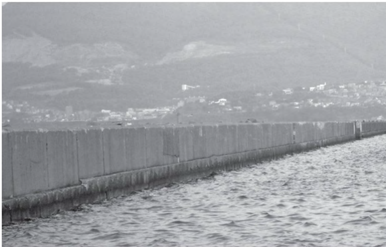
小樽港北防波堤
