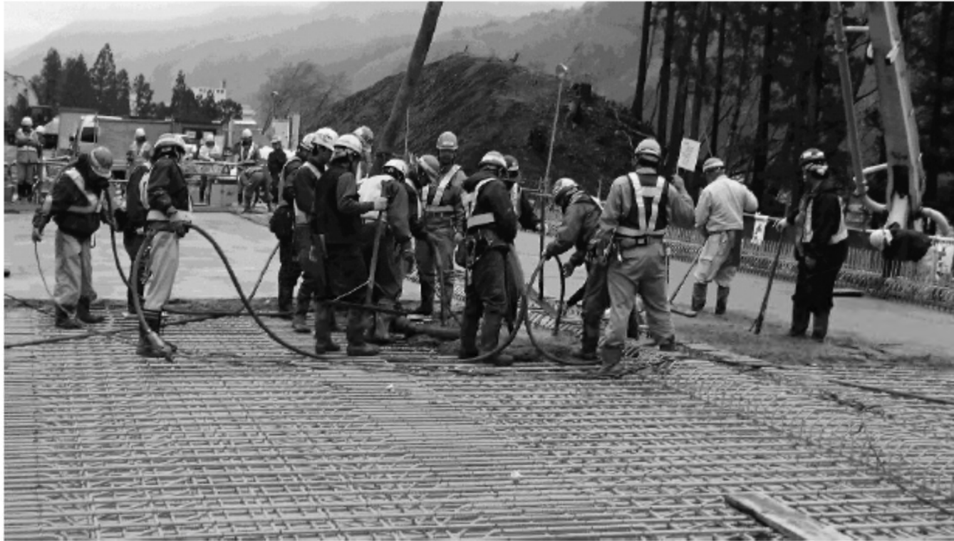
向定内橋の施工
