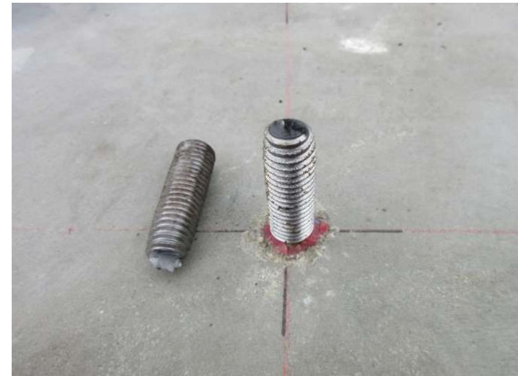
破断した標準施工ボルト
