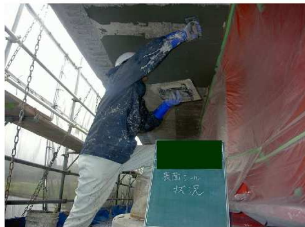
写真 4-2 表面漏出防止工(表面シール工)
