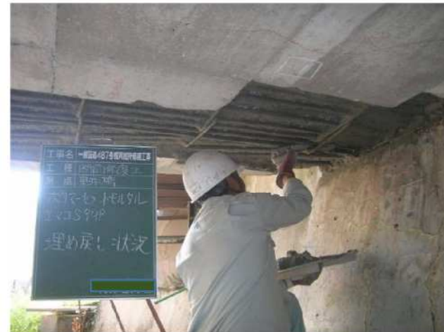
写真 4-5 断面修復状況
