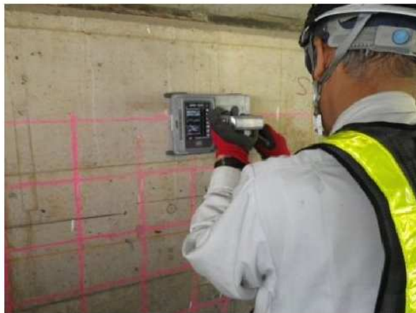
写真 4-4 鉄筋探査状況
