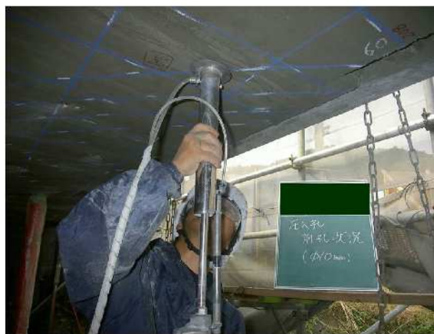
写真 4-5 削孔状況(ダイヤモンドコアドリル)
