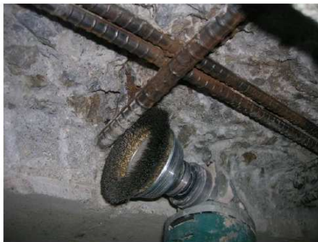
写真 4-3 鉄筋ケレン状況
