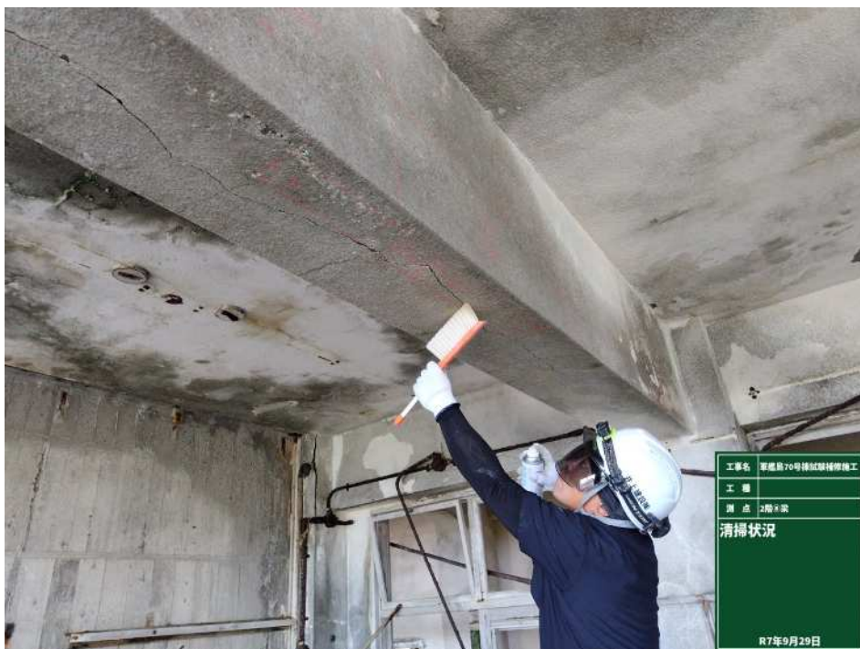
はり下面のひび割れ状況
