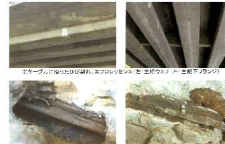
ポストテンション方式PC橋の主ケーブルで腐蝕された腐蝕部
