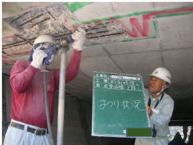
写真 4-1 人力によるはつり作業状況
