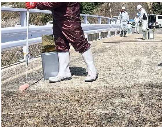
写真 4-2 亜硝酸リチウム系表面含浸材塗布工の施工状況
