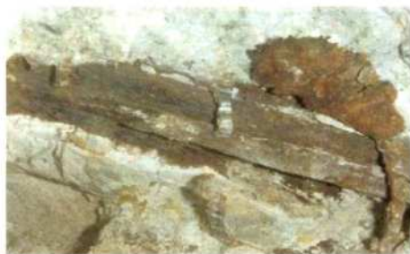
ポストテンションPCT桁橋の主ケーブルで確認された著しい鋼材腐食
