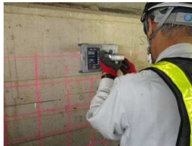
写真 4-4 鉄筋探査状況
