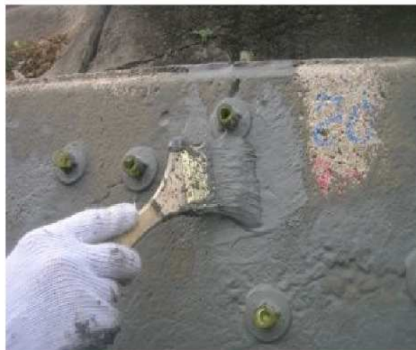
写真 4-3 ひび割れシール工の施工状況
