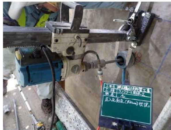
写真 4-5 削孔状況(ダイヤモンドコアドリル)
