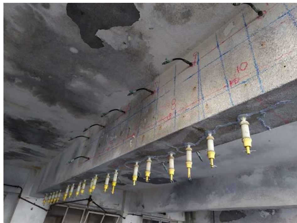
ひび割れ注入工「リハビリシリンダー工法」 施工状況
