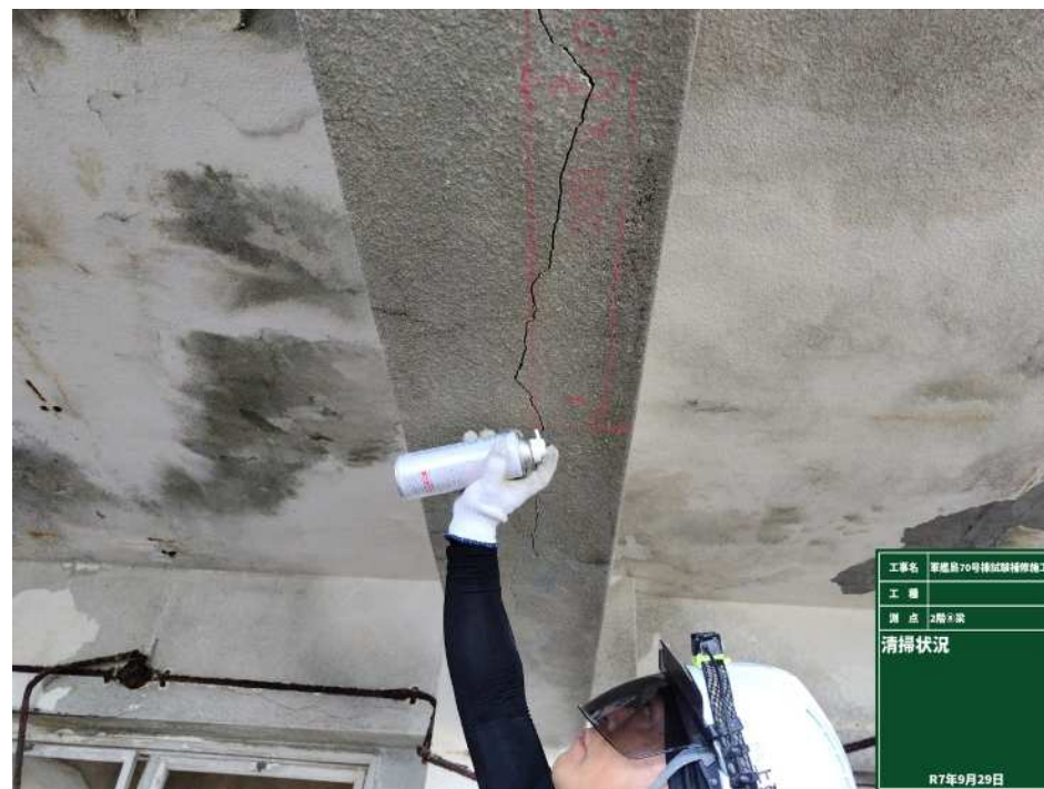
はり下面のひび割れ状況
