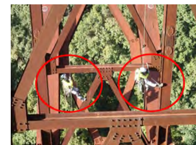
ロープ高所作業
