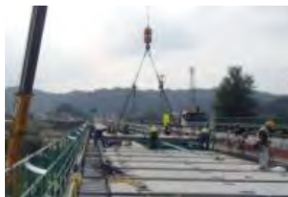
プレキャスト床版による 打ち替え
