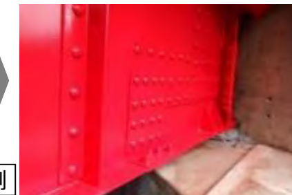
桁端部の当て板・塗装
