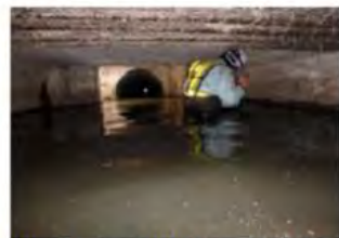
滞水した溝橋内部の目視点検
