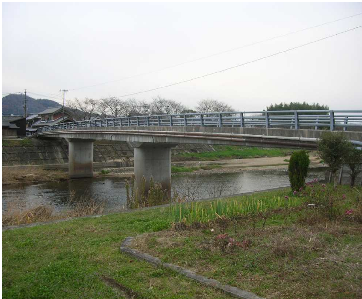
写真1 対象橋梁の全景
