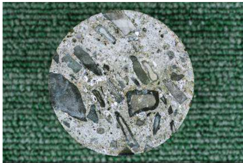
写真5 コア切断面の状況
