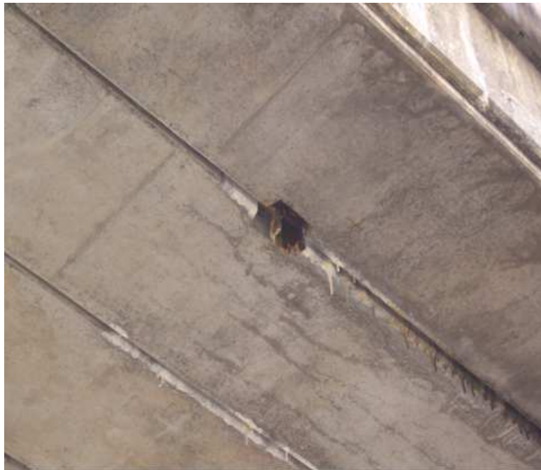
写真3 桁下面の状況
