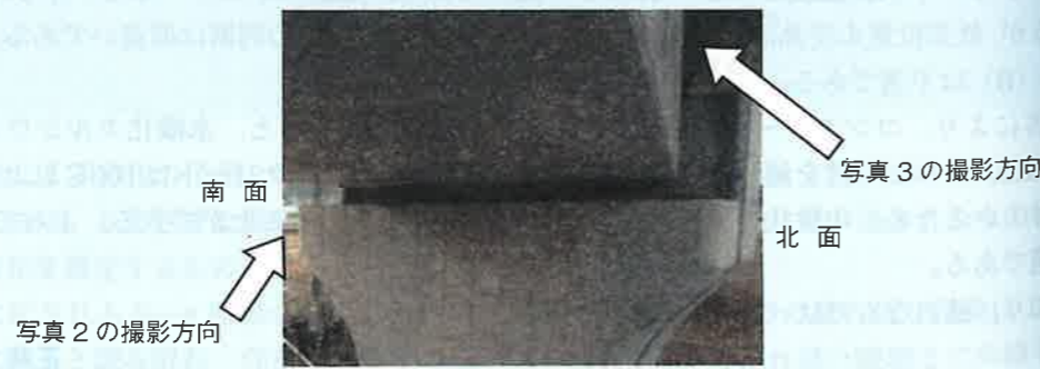
写真1 道路橋PC単純箱桁橋
