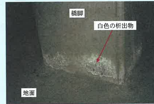
写真 鉄道高架橋の鉄筋コンクリート橋脚（中柱）の基部
